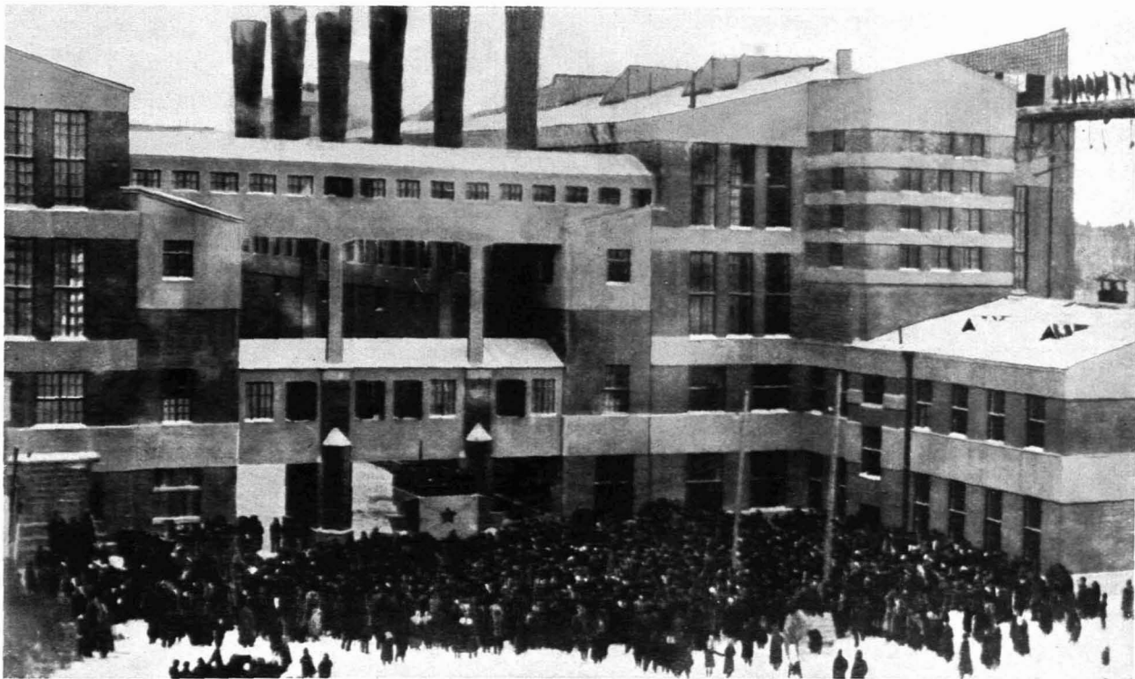
MOSKAU / 266 / MOSCOW Torfkraftwerk Schaturka Power Stations
