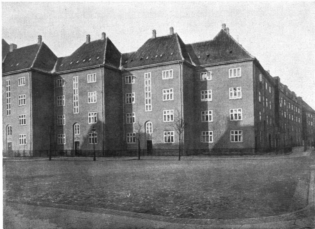
242 / COPENHAGEN Prinzessin Charlottesgade. Gemeindlicher Wohnungsbau (vgl. Abb. 240) Arch.: Ström Tejsen
