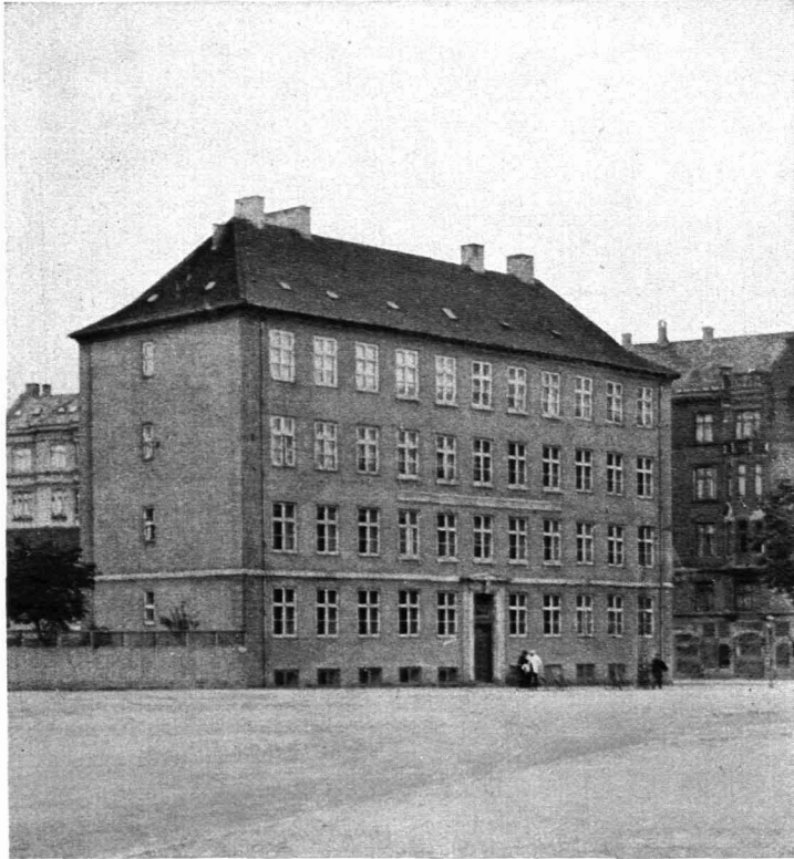
237 / COPENHAGEN Jagdvej. Bürogebäude. Municipal Office Building Nach dem Entwurfe des Stadtarchitekten
