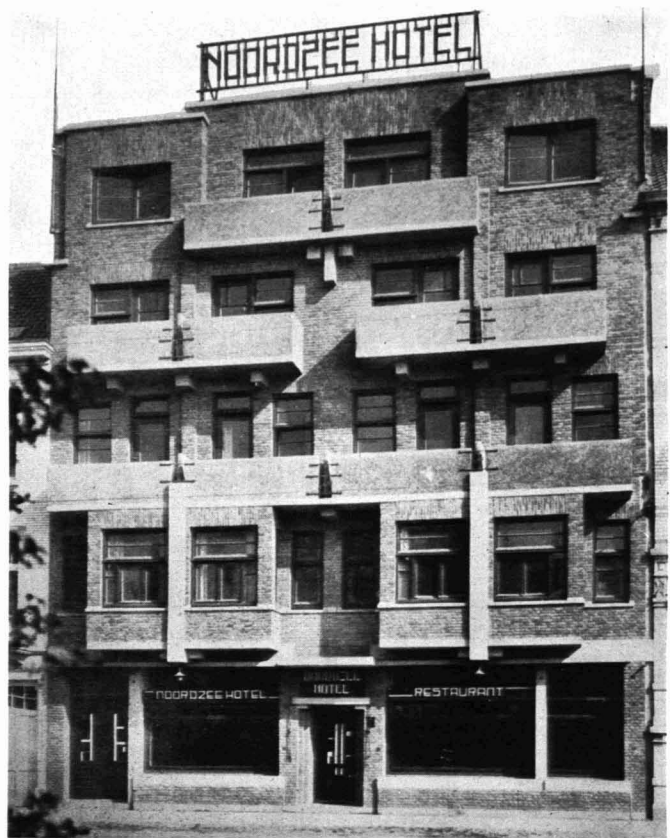
218 / KNOCKE Hotel Arch.: Huib. Hoste
