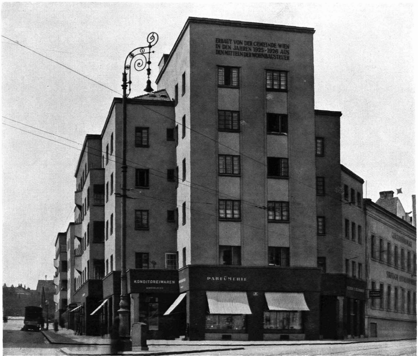
WIEN / 187 / VIENNA Pestalozzihof Flats: Pestalozzihof Arch.: Ella Briggs
