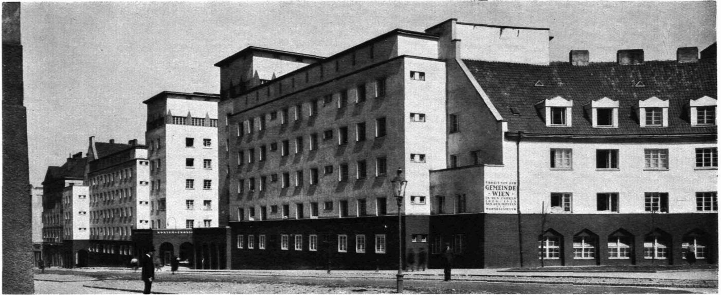
176-77 / WIEN Fuchsenfeldhof, Letzter Bauabschnitt. Arch.: Schmid und Aichinger 176-77 / VIENNA Fuchsenfeldhof. Municipal Dwelling houses. Arch.: Schmid and Aichinger
