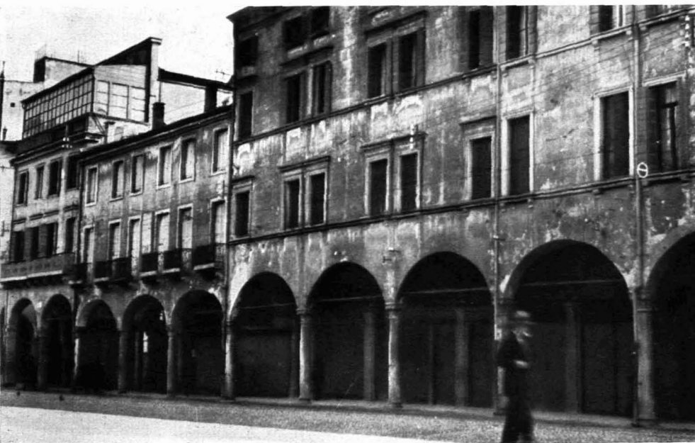
Kolonnaden / Übergang von den Säulenstraßen der antiken Stadt zur modernen „Fassaden“-Stadt
