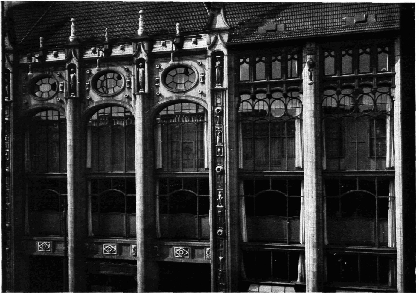
37 / BERLIN, LEIPZIGER STRASSE. EINBAUTEN HINTER DEN FENSTERN DES WARENHAUSES WERTHEIM Architekt: Alfred Messel
