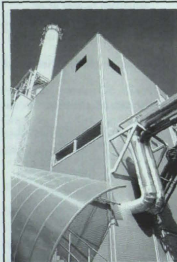
GuD - Anlage Moderne Cogenerationstechnologie zur Energieversorgung (Strom und Dampf) des Industriestandortes SFT Graz und des Fernwärmenetzes der Stadt Graz. Leistung: 25 MW elektrisch und 3 - 30 MW thermisch für SFT Graz sowie 35 MW thermisch für Fernwärme Graz.(OMVAG)
