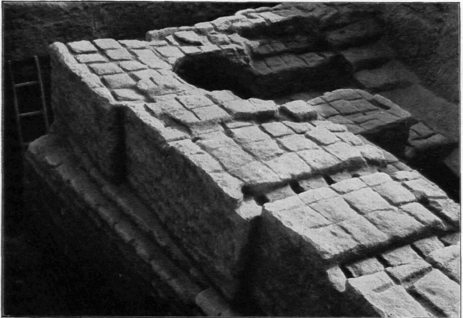
Abb. 239: Nordostecke des „großen Hauses“ im Merkes.
