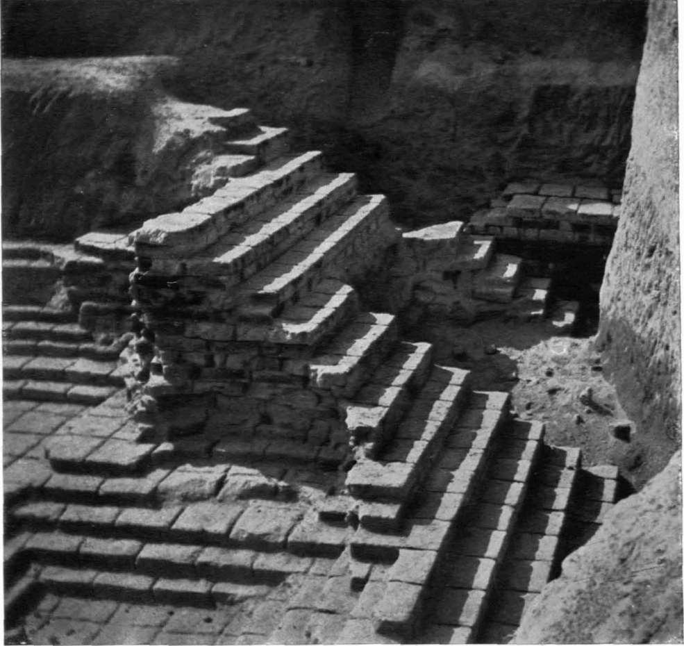
Abb. 121 a: Die erhaltenen Treppenstufen zum babylonischen Turm.
