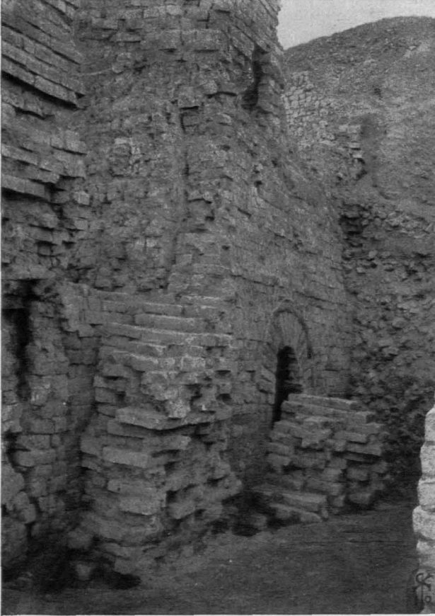
Abb. 72: Pforte in der Südmauer der Südburg.
