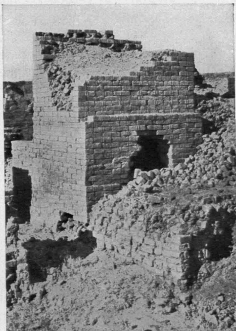
Abb. 71: Zweistrichiges Mauerwerk in der Südburg.
