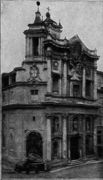
Abb. 61. Borromini, Fassade von S. Carlo alle quattro fontane
