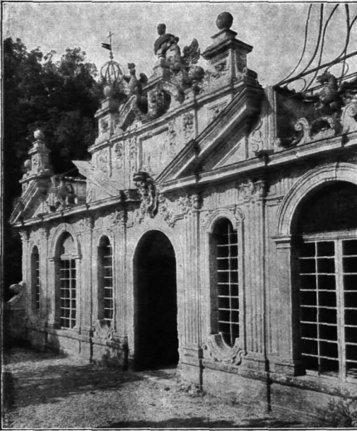
Abb. 37. Villa Borghese, Das Vogelhaus
