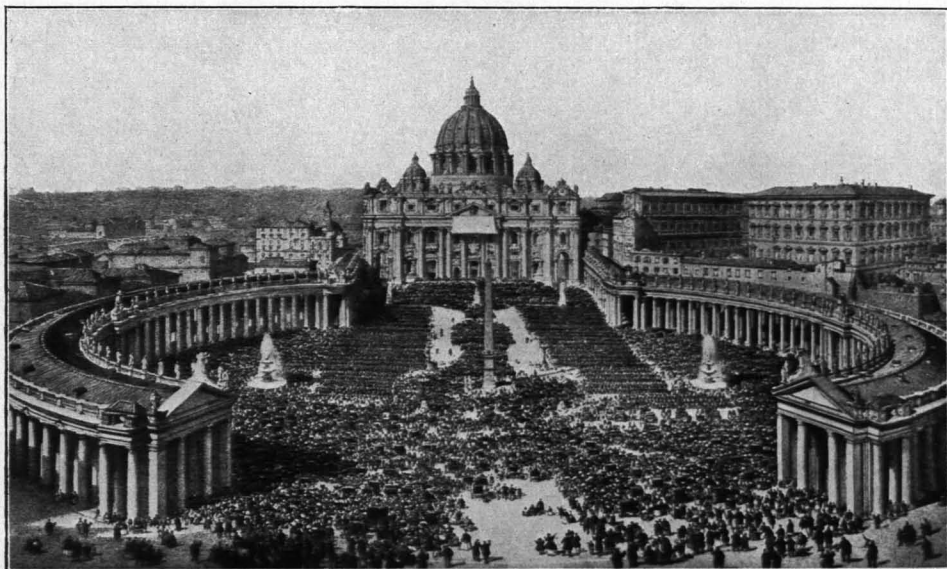
Abb. 55. Bernini, Die Kolonnaden am Petersplatz (1663)
