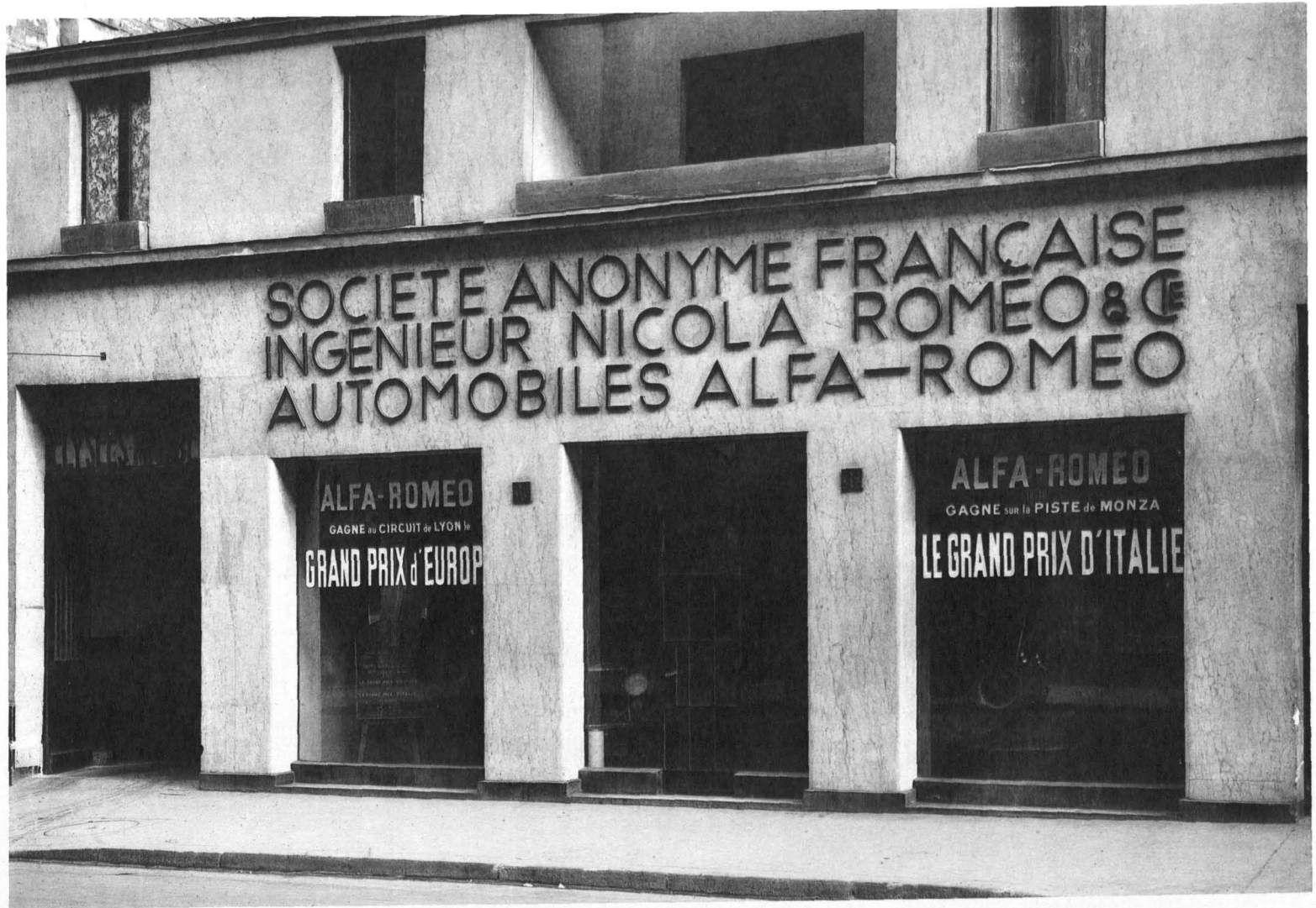
FASSADE EINES KAUFHAUSES VON ROB. MALLET-STÉVENS.
