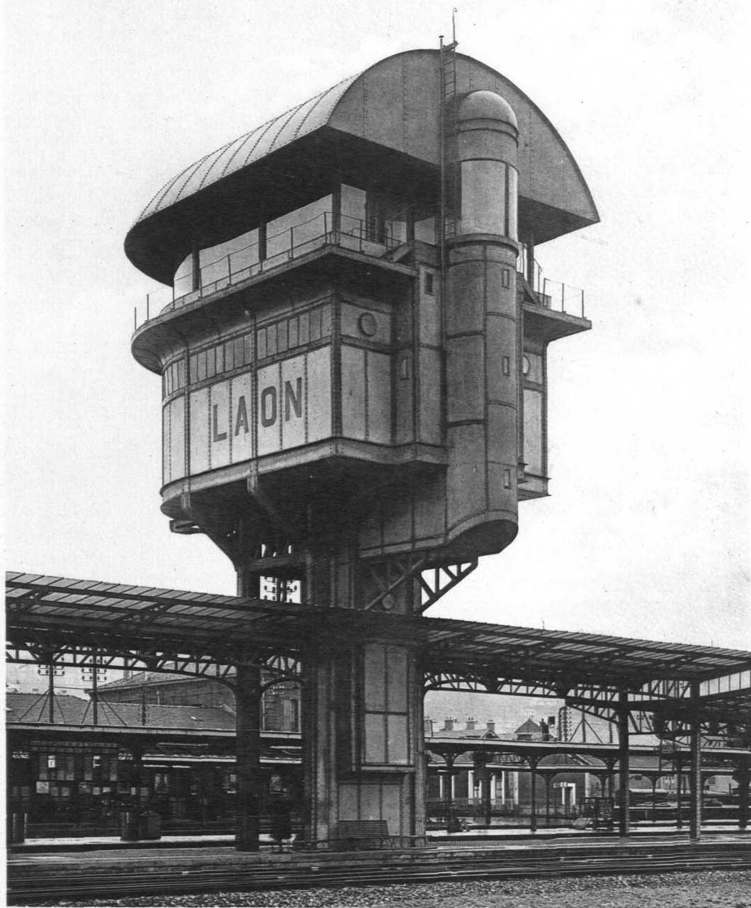
SIGNALMAST DER COMPAGNIE DES CHEMINS DE FER DU NORD.
