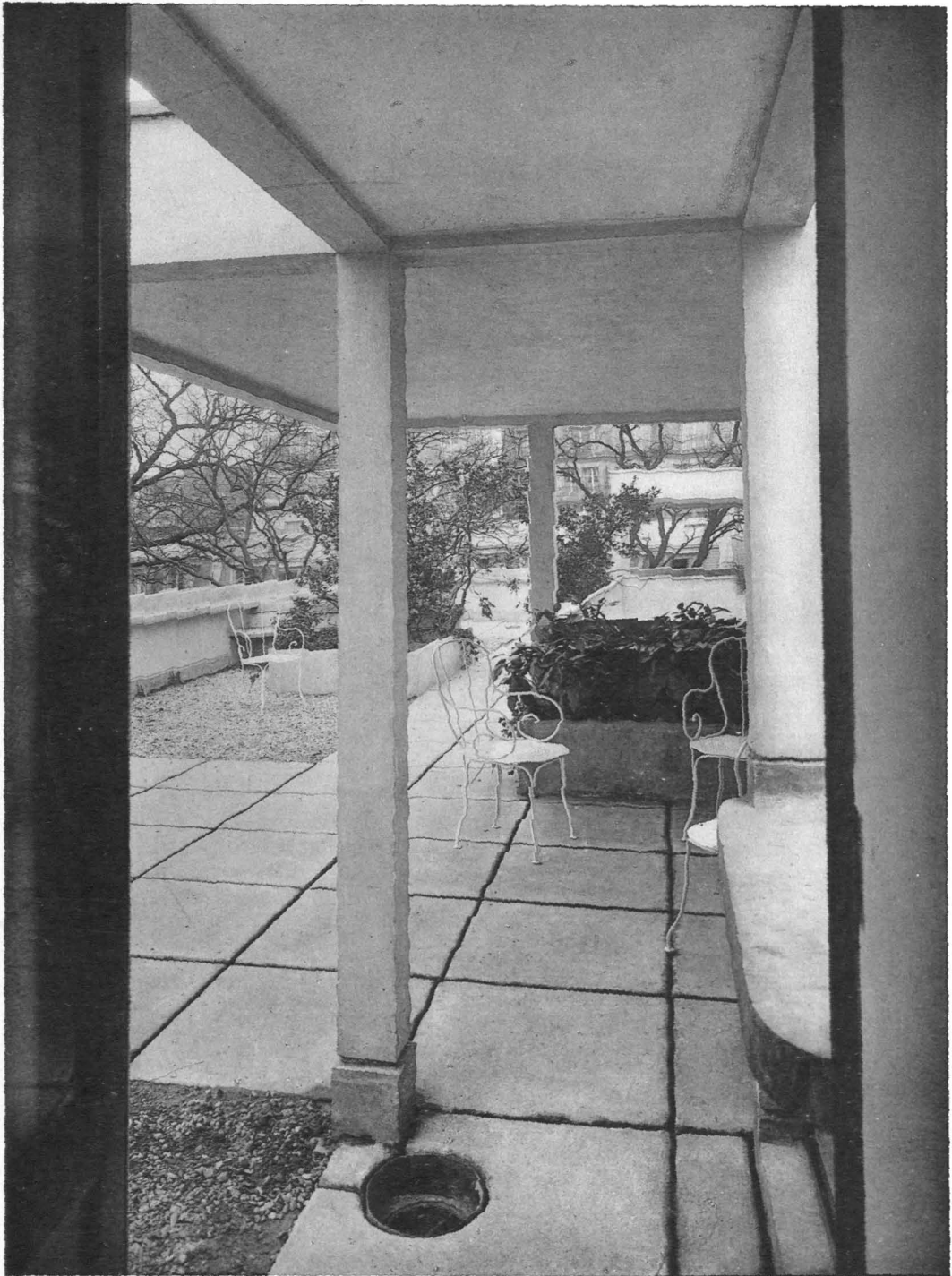
DACHTERRASSE EINES PRIVATHAUSES VON LE CORBUSIER UND PIERRE JEANNERET.
