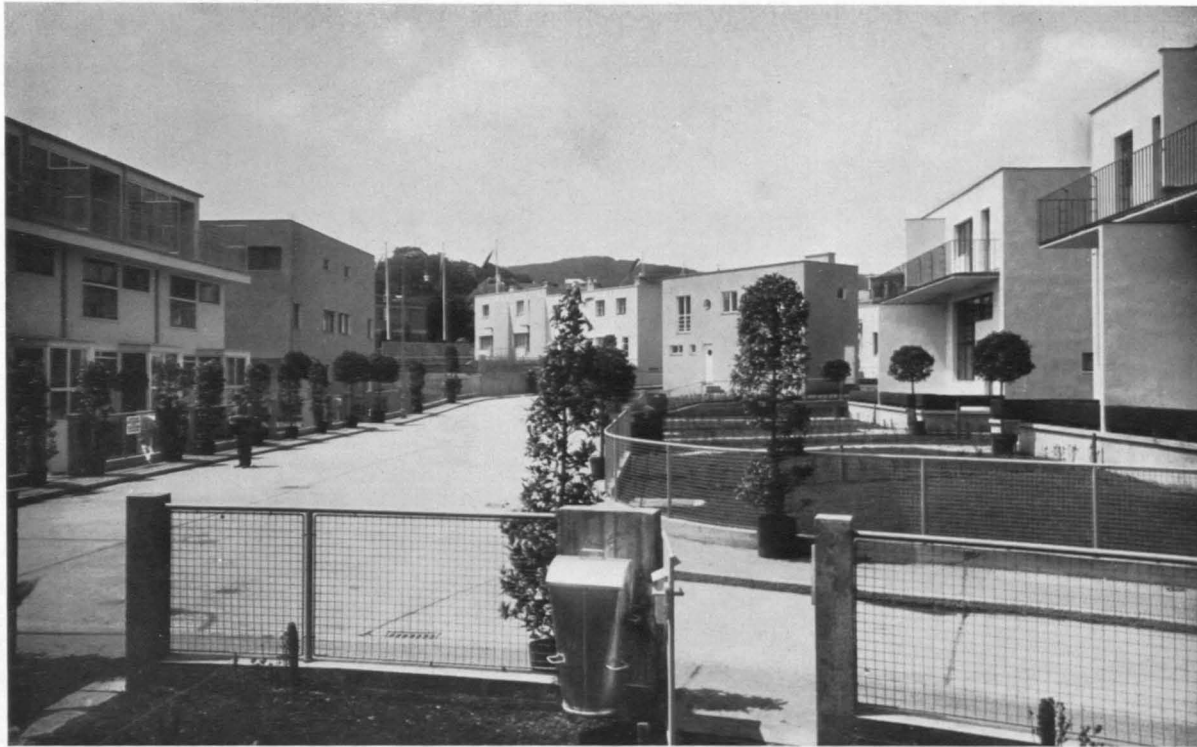
Abb. 8. Blick auf den Platz mit den Häusern von Rietveld, Guevrekian, Schütte-Lihotzky, Fellerer, Vetter, Adolf Loos
