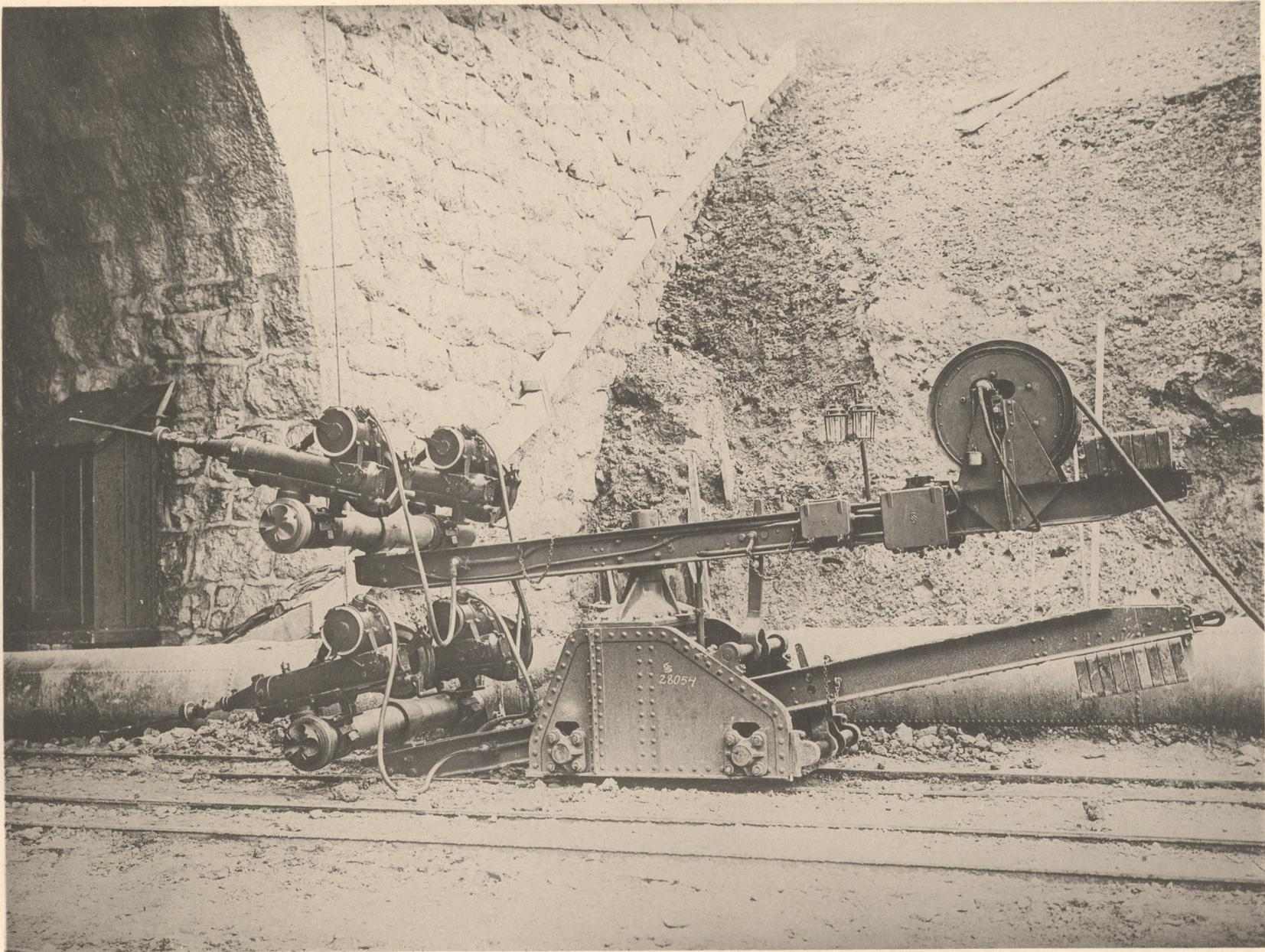
Bohrwagen mit 4 elektrisch angetriebenen Kurbelstoss-Bohrmaschinen
