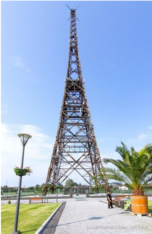
Abbildung 2-22: Sendeanlage in Gleiwitz, Polen, Holzfachwerkurm, errichtet 1935 [33]
