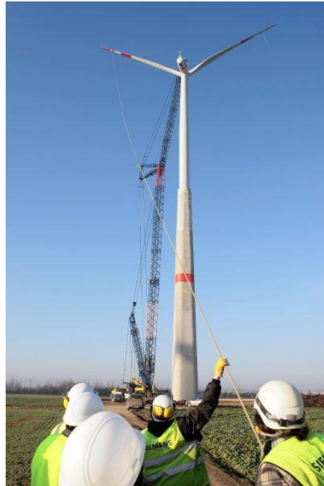
Abbildung 2-12: Montage eines Beton-Stahl-Hybridturmes [22]
