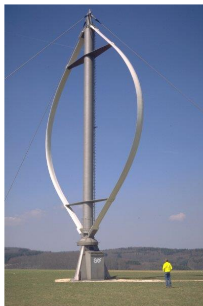
Abbildung 2-6: Windkraftanlage mit vertikaler Turbinenachse („Darrieus-Rotor“) [17]
