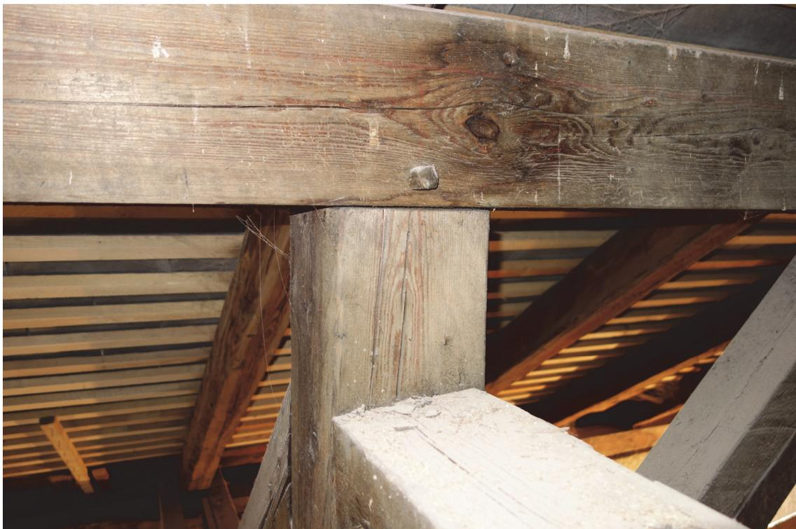
Abb. 59 Knotenpunkt Stuhlsäule – Mittelpfette, Osttrakt, Achse 14. Erkennbar ist auch der Holznagel, der durch den innenliegenden Zapfen reicht.
