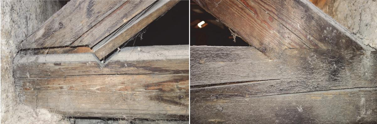
Abb. 75 Klaffung bei Strebenfußpunkt aufgrund der Verdrehung der Strebe; Osttrakt, Achse 14
