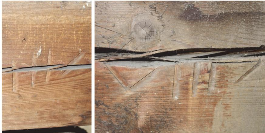
Abb. 73 Abbundmarken auf Schwindrissen als Indiz für den Einbau von feuchtem Bauholz
