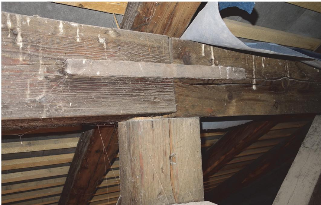
Abb. 78 Verdrehung der Mittelpfette bei einem Pfettenstoß; Osttrakt, Achse 13, Straßenseite
