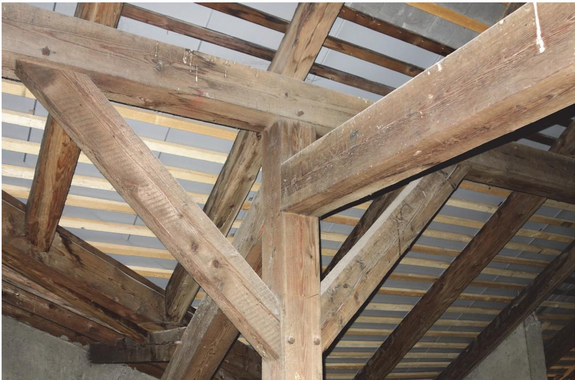
Abb. 61 Kopfbandanschluss, Ostrakt, Achse 9, Straßenseite
