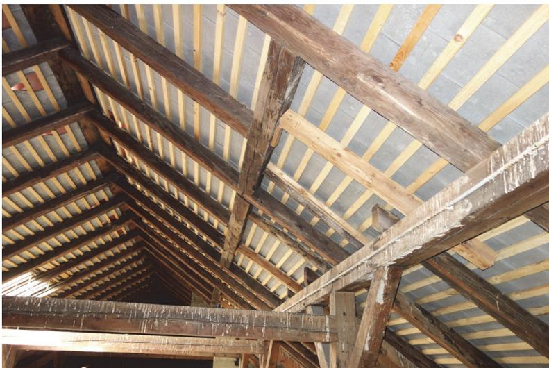
Abb. 72 Sparrenauswechslung für ehemalige Kamindurchführung und provisorische Verschließung
