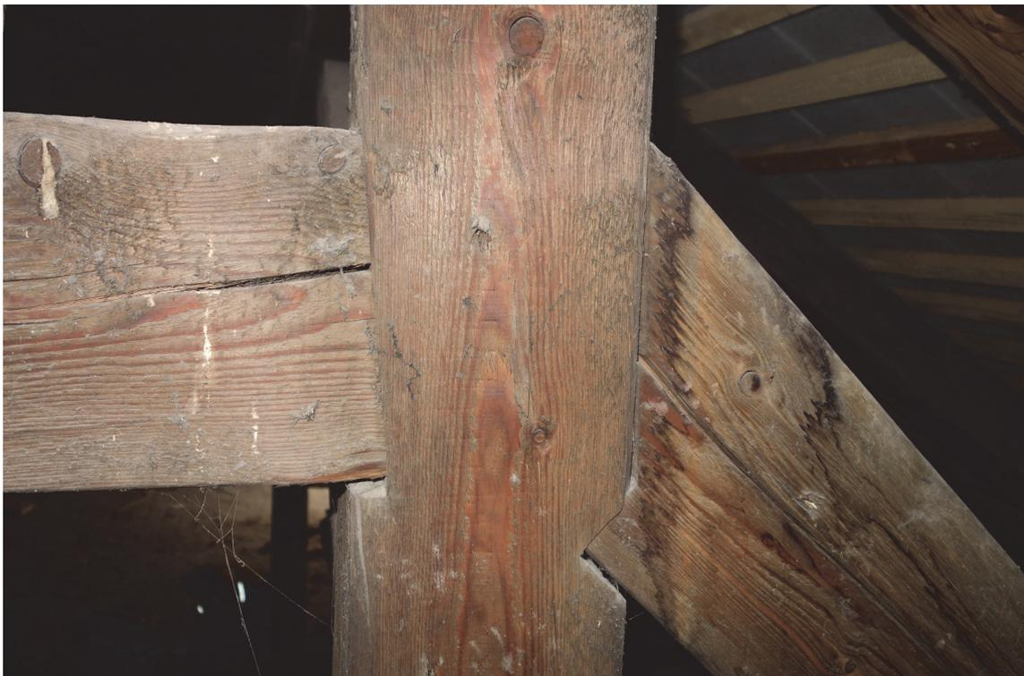
Abb. 50 Knotenpunkt Strebe-Stuhlsäule-Druckriegel, Osttrakt, Achse 11, Straßenseite
