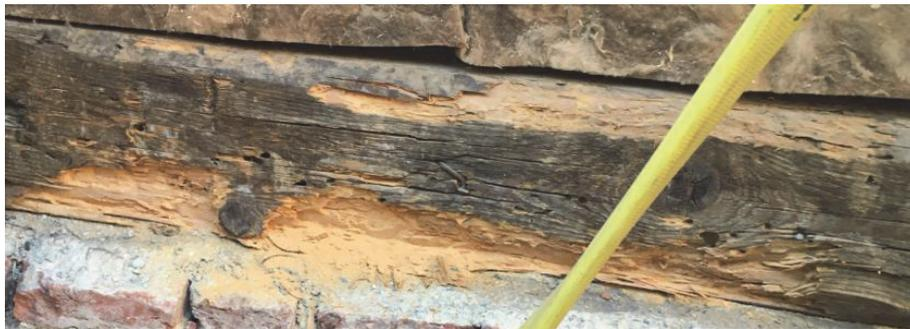
Abb. 66 Schadhafte Mauerbank; Westtrakt, Achse 11-12
