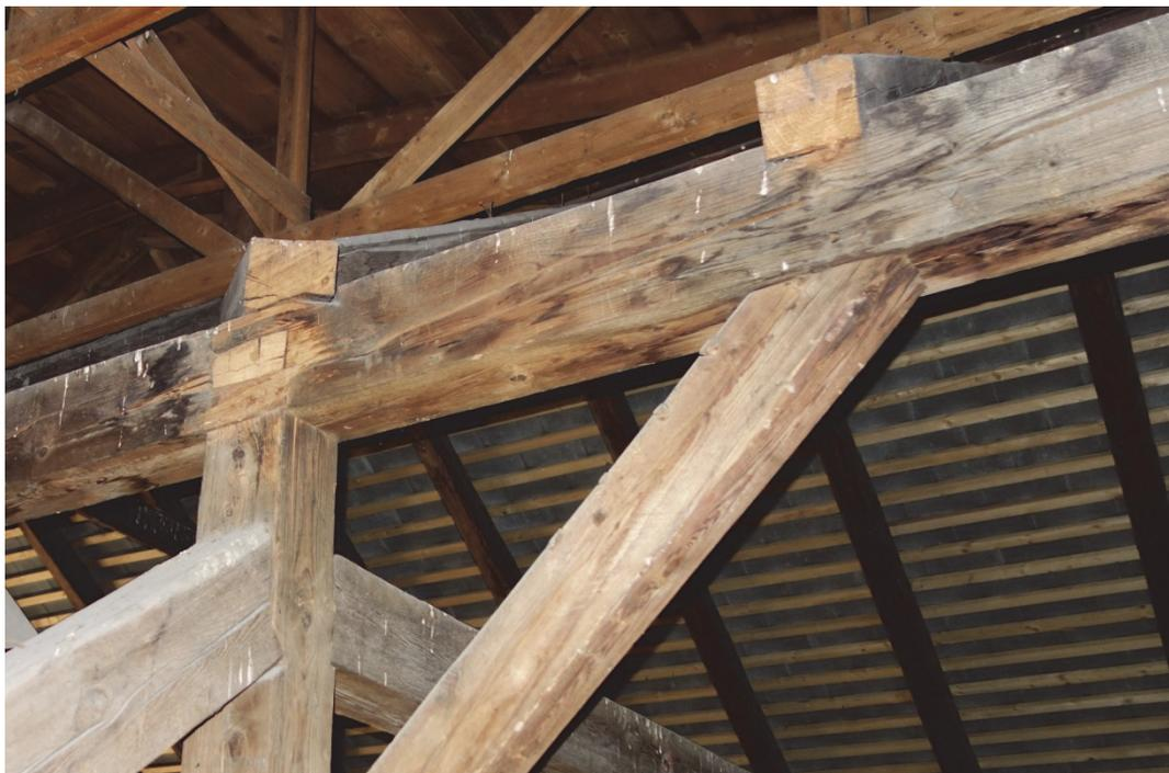
Abb. 70 Abgeschnittener Ichsens- und Schiffsparren. Über der Stuhlsäule wurde die Mittelfette des Mitteltraktes eingezapft, welche auch entfernt wurde.
