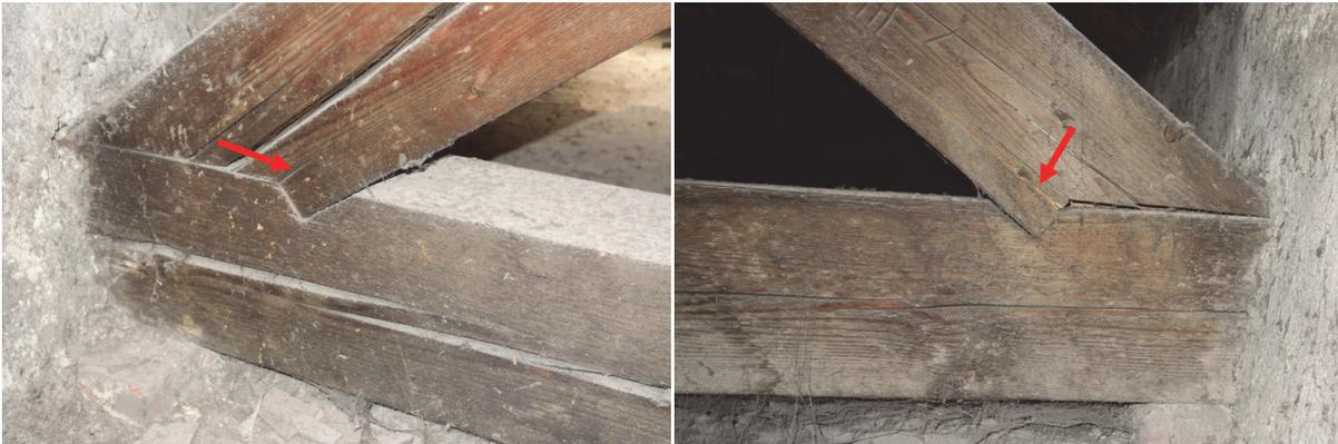
Abb. 76 Risse an der Strebenverbindung; Westtrakt, Achse 13, Hofseite. Der Riss an der Kante der Druckfläche ist durch die Pfeile markiert.
