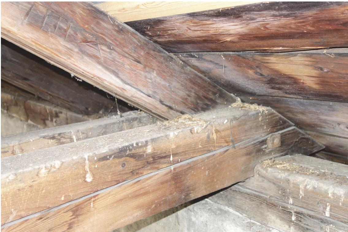
Abb. 56 Anschluss der Zangen an die Mauerbank, Westtrakt, Achse 3, Hofseite
