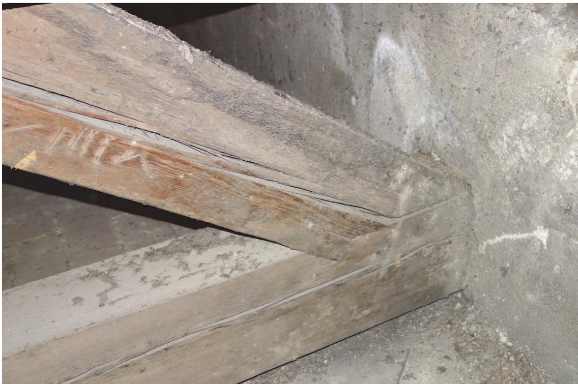
Abb. 48 Anschluss Strebe-Bundtram, Westtrakt, Achse 12, Hofseite. Erkennbar ist auch das Abbundzeichen VIII/..
