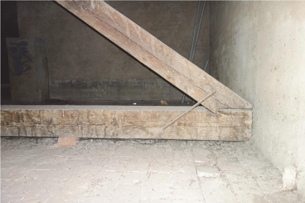
Abb. 71 Gekappter Bundtram und fragwürdiges Auflager auf der Dippelbaumdecke des darunterliegenden Gangbereichs im Westtrakt
