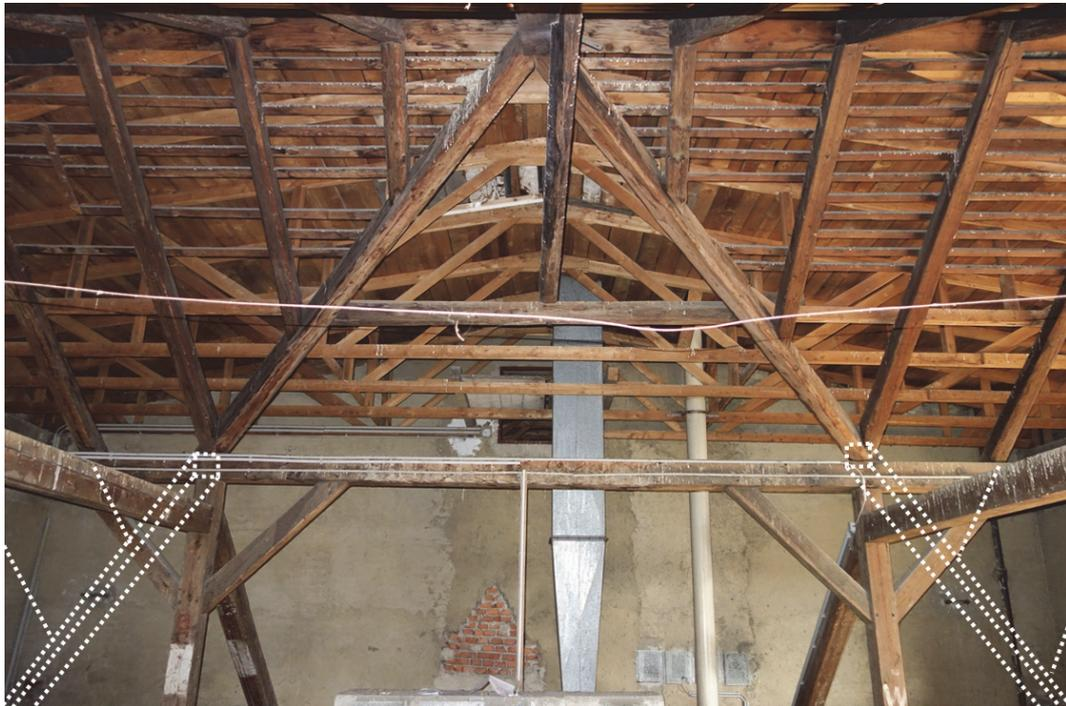
Abb. 69 Mittelbereich Westtrakt. Die Ichsensparren und die Sparren sind an der Mittelfette abgeschnitten.
