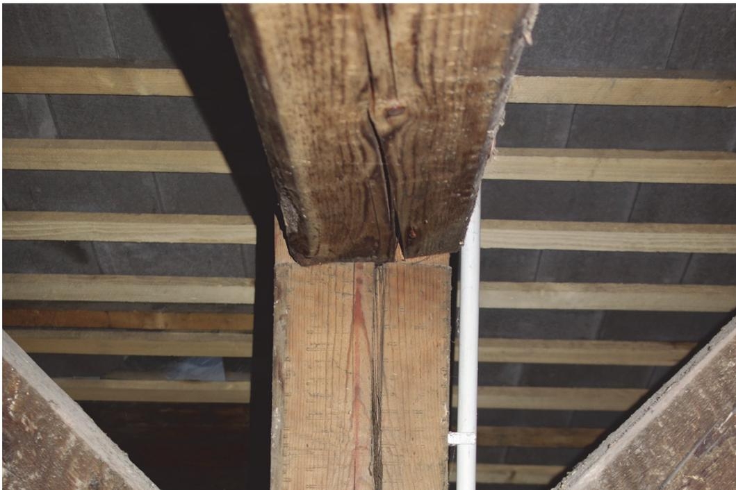
Abb. 74 Verdrehter Druckriegel; Osttrakt, Achse 7
