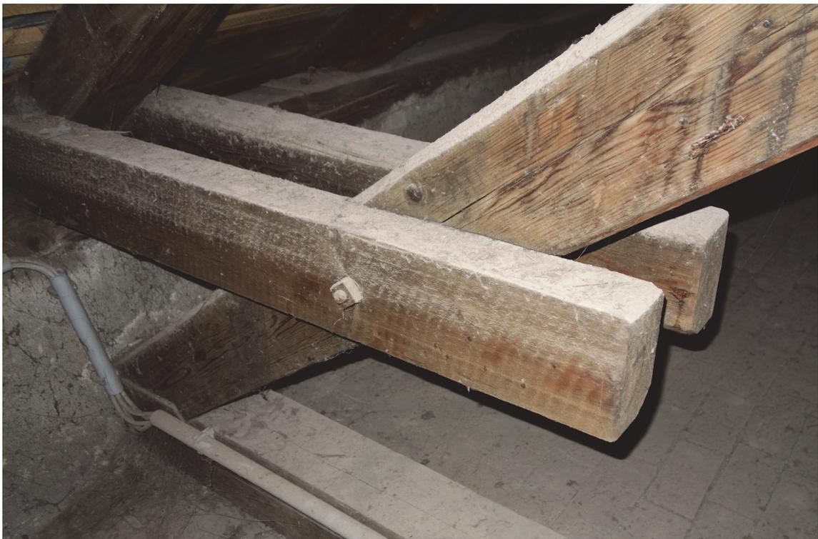
Abb. 54 Anschluss der Zangen an die Strebe, Osttrakt, Achse 12, Hofseite
