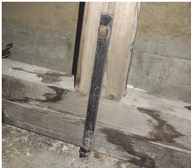
Abb. 52 Verbindung Stuhlsäule-Bundtram mit Zapfen und Hängeeisen, Osttrakt, Achse 8, Hofseite
