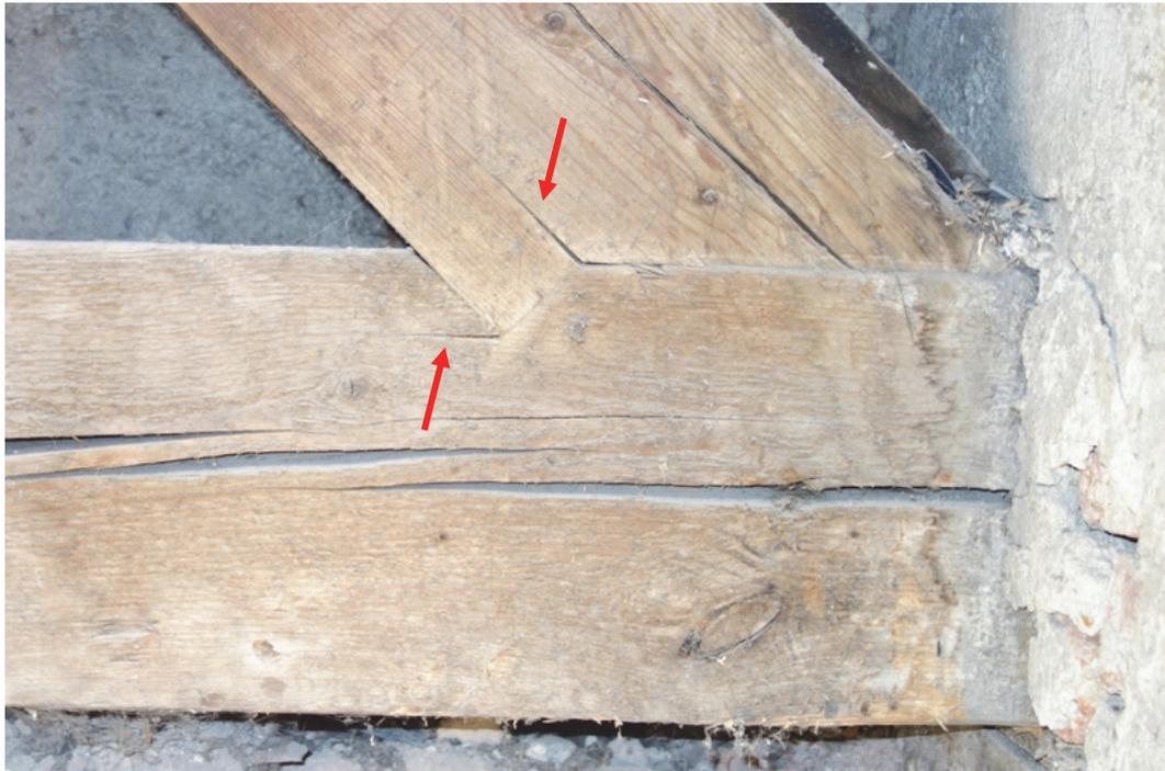
Abb. 77 Risse an der Strebenverbindung; Osttrakt, Achse 15, Straßenseite. Die Risse deuten auf eine Überlastung der Verbindung hin. Hier ist auch ein Riss im Bundtram zu bemerken.
