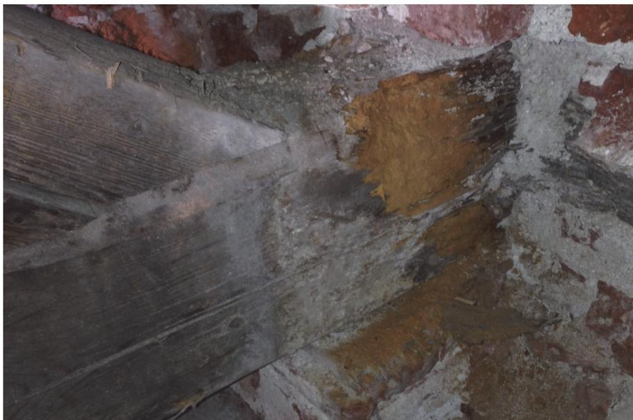
Abb. 65 Im Zuge der Bauarbeiten gefundener schadhafter Bundtramkopf; Osttrakt, Achse 11, Hofseite
