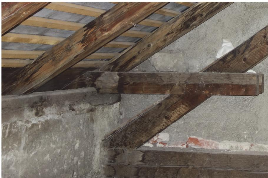
Abb. 67 Wasserspuren an den Bauteilen; Osttrakt, Achse 15, Hofseite
