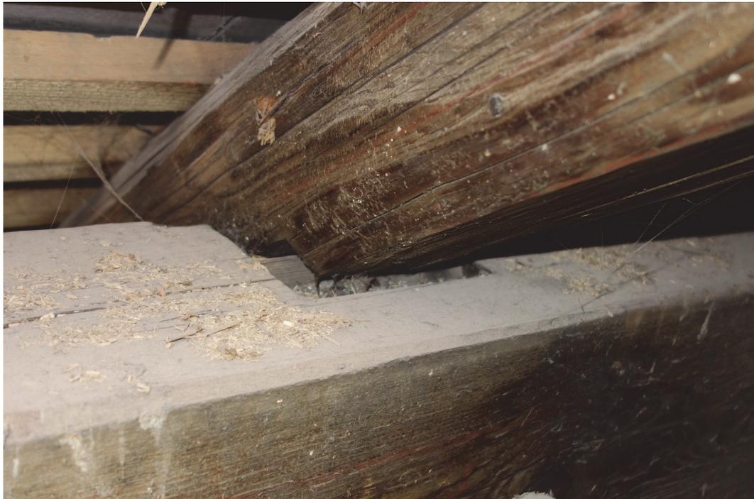
Abb. 64 "Gaißfuß" an einer Sparren-Mittelpfetten Verbindung
