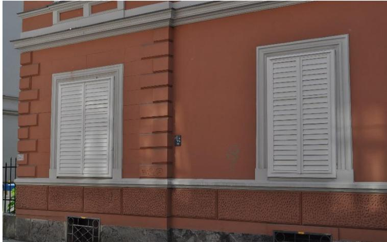
Abb. 75: Außenansicht der zugemauerten Fenster vom untersuchten Raum
