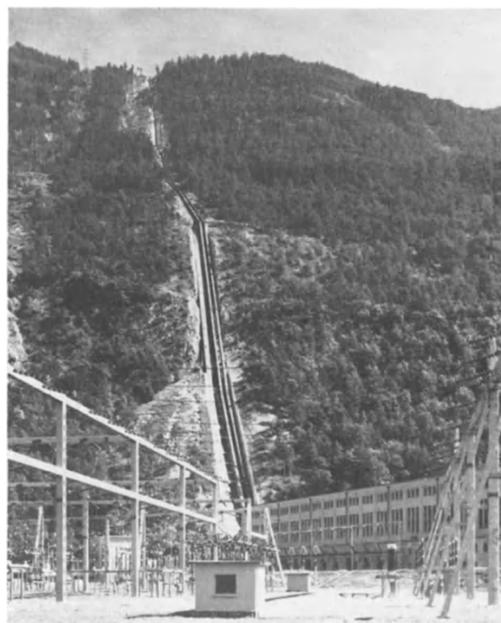
Abbildung 12 Offen verlegte Druckleitungen zum Kraftwerk Riddes der Mauvoisin S.A., Wallis
