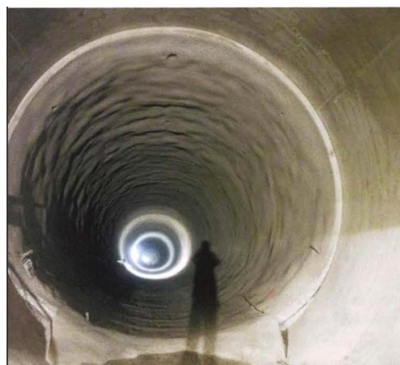
*Abbildung 60 fertige Spritzbetonschale (45)*
