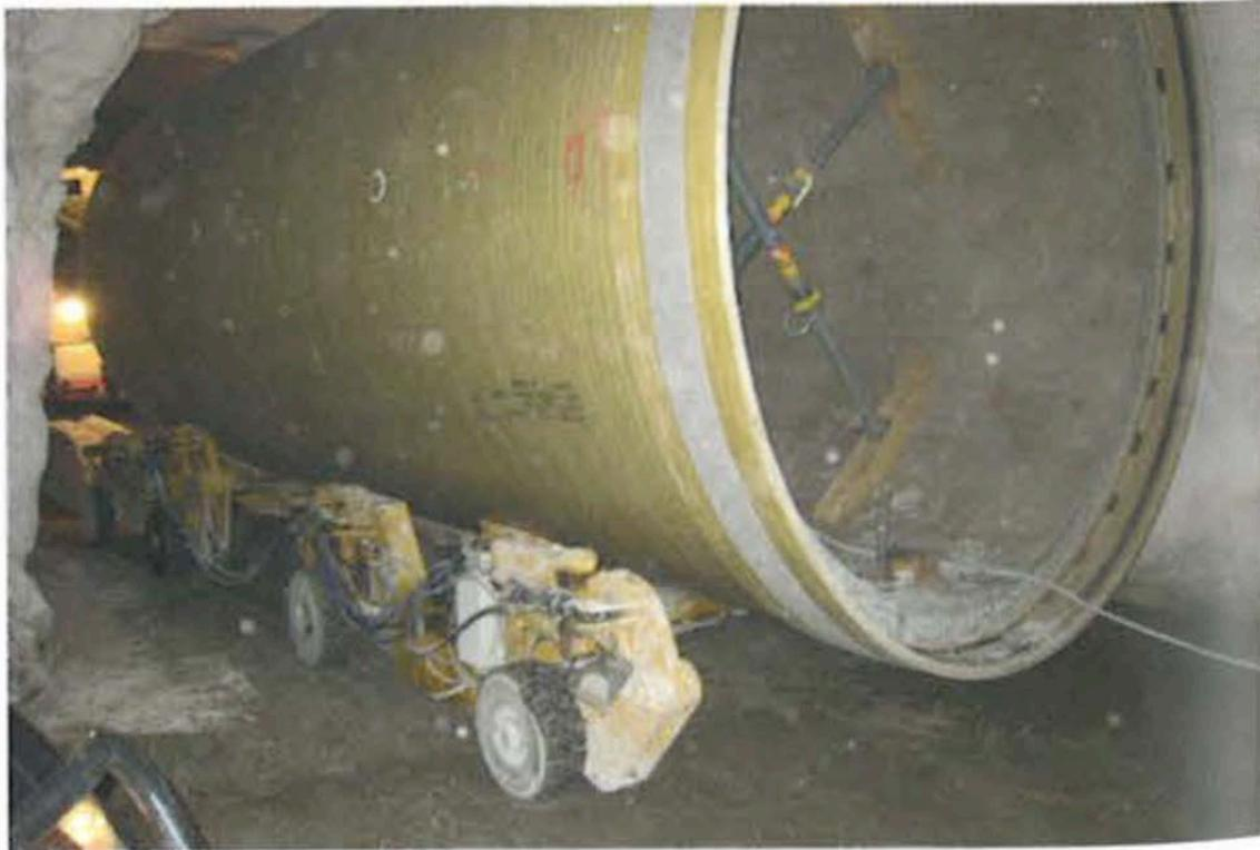
Abbildung 77 GFK - Rohr mit Transportwagen (53)
