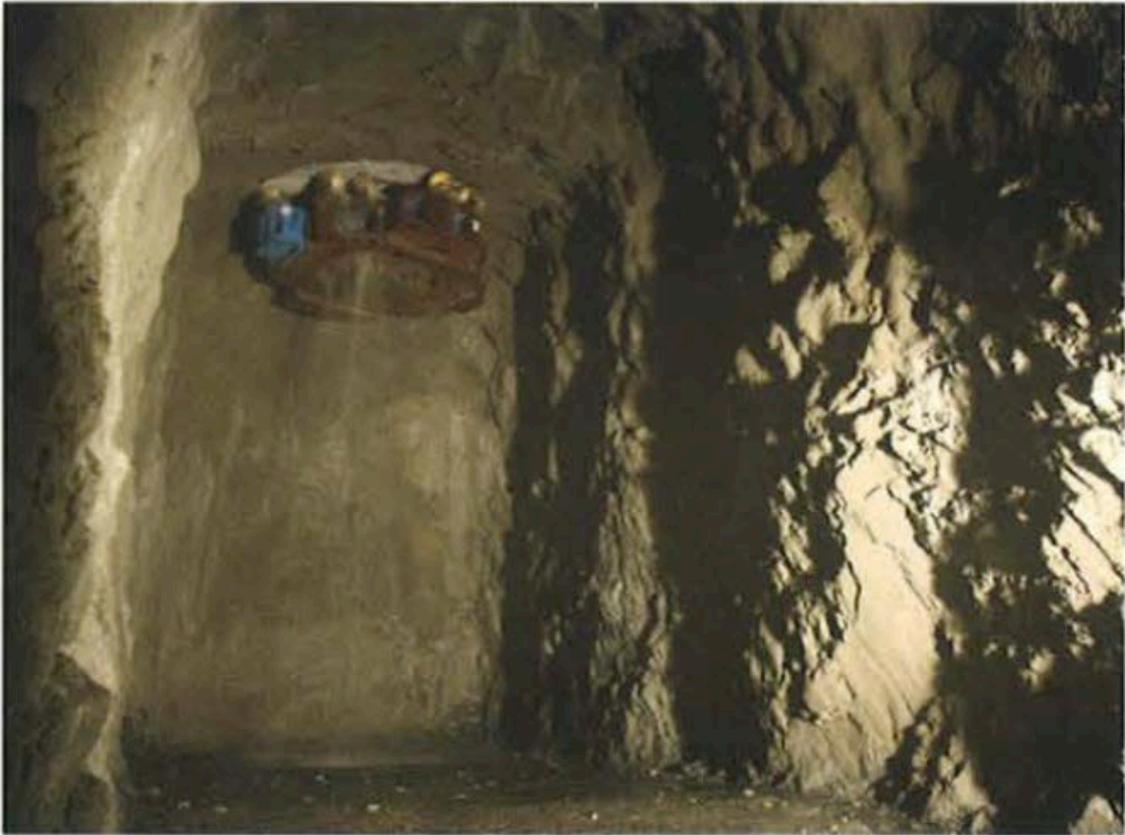
Abbildung 71 Aufweitung des Schachtes mittels Raising (53)
