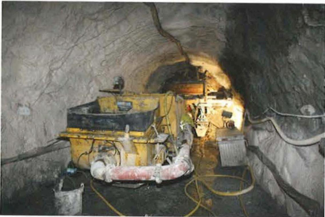
Abbildung 75 Betonpumpe vor Abschaltung (53)
