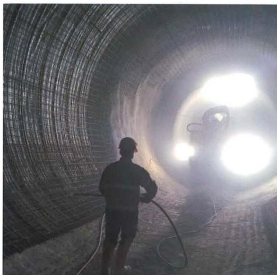
*Abbildung 59 Die Spritzbetonarbeiten im Druckstollen konnten durch Testreihen mit einem minimalen Rückprallanteil durchgeführt werden. (45)*
