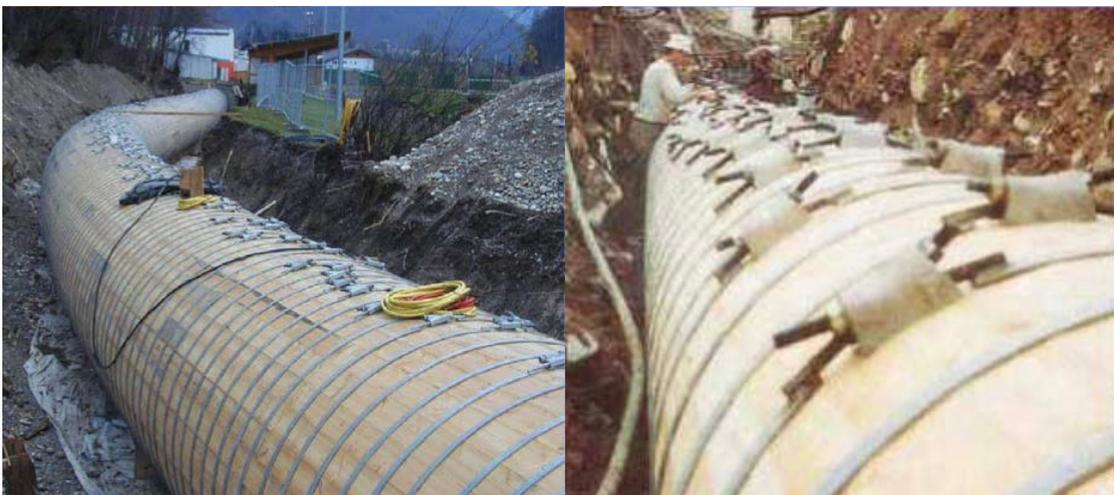
Abbildung 22 Druckrohrleitung aus Holz (22)
