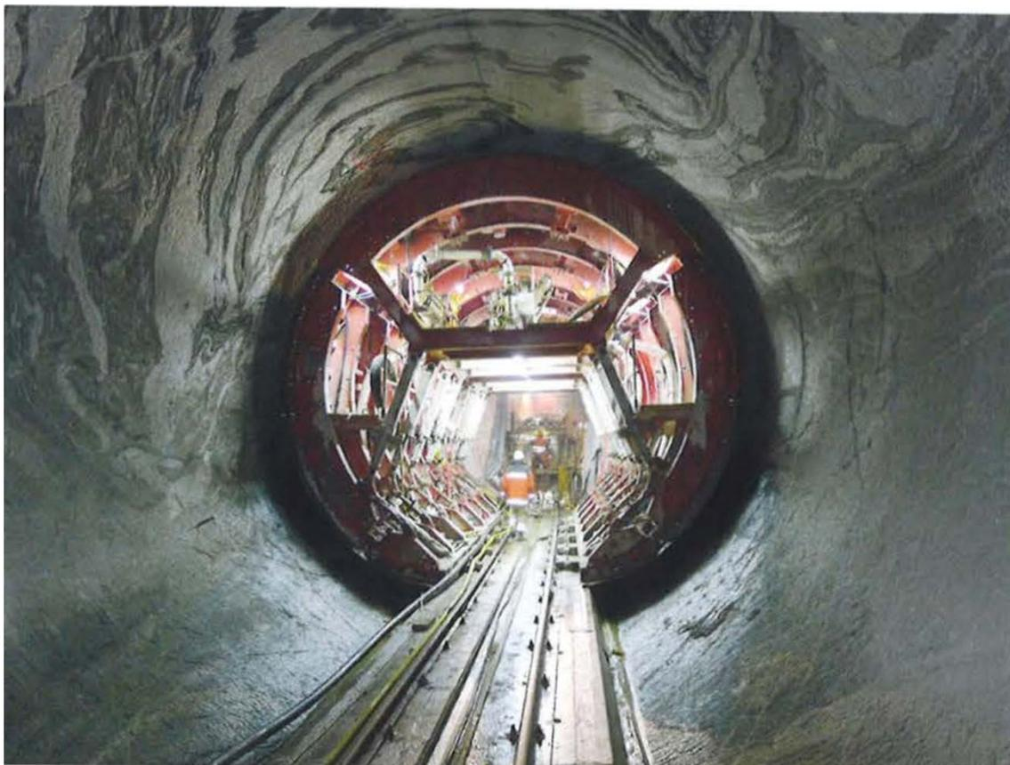
Abbildung 58 Tunnelblick: Herstellungsarbeiten der Innenschale im Druckstollen (45)
