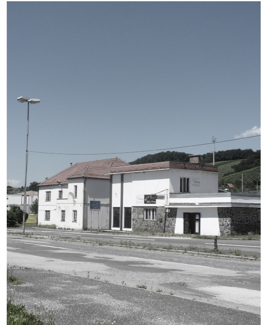
Abbildung 53: Blick auf die Gebäude von Süden
