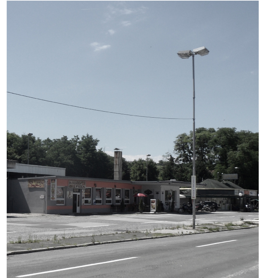
Abbildung 18: Teil der alten slowenischen Grenz- kontrolle mit neuer Nutzung
