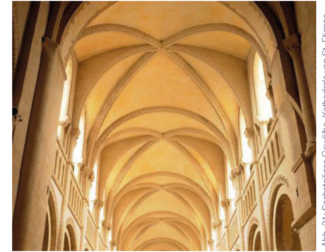
Abb. 31: Sechsteiliges Gewölbe, Kathedrale von St. Étienne
