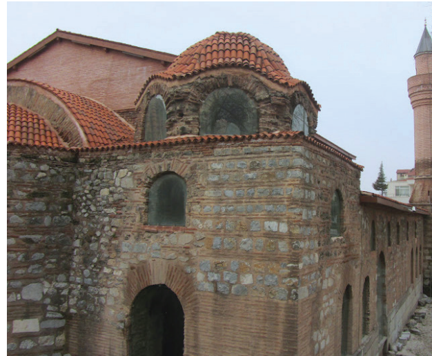
Abb. 17: Verbundmauerwerk, Hagia Sophia, Iznik, Türkei
