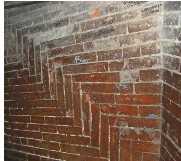
Abb. 51: Fischgrätenmuster im Inneren der Kuppel
