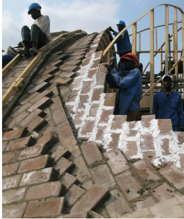
Abb. 53: Katalanisches Gewölbe, Mapungubwe Interpretation Center, Südafrika
