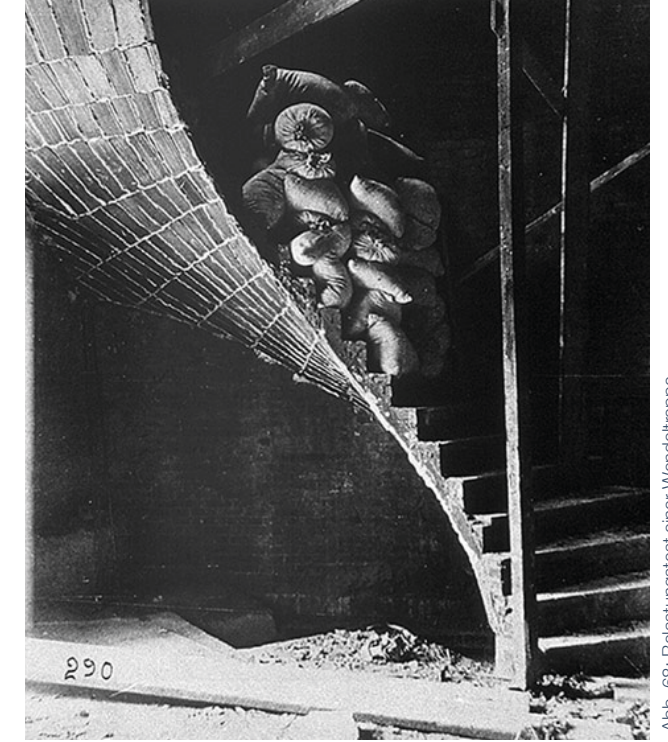
Abb. 68: Belastungstest einer Wendeltreppe
