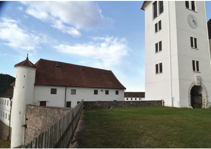
Abb. 170: Blick auf den Bauplatz mit Uhrturm
