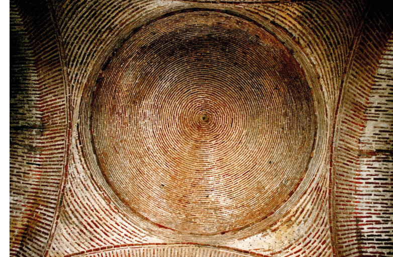
Abb. 21: Mauerwerk, Pendentivkuppel, Istanbul
