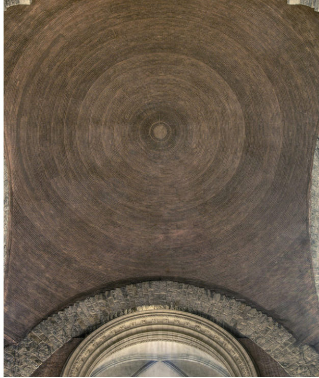
Abb. 63: Untersicht mit Ringschichten
