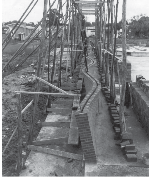
Abb. 77: Christo Obrero - Kirche, Baustellenfoto
