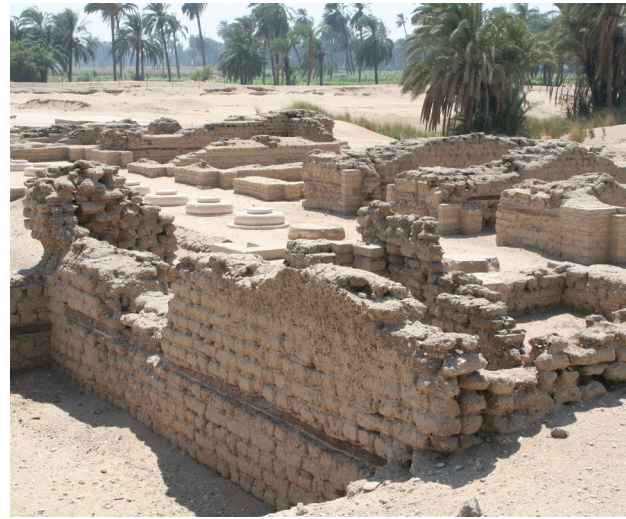
Abb. 2: Altägyptisches Lehmziegelgebäude, Amarna
