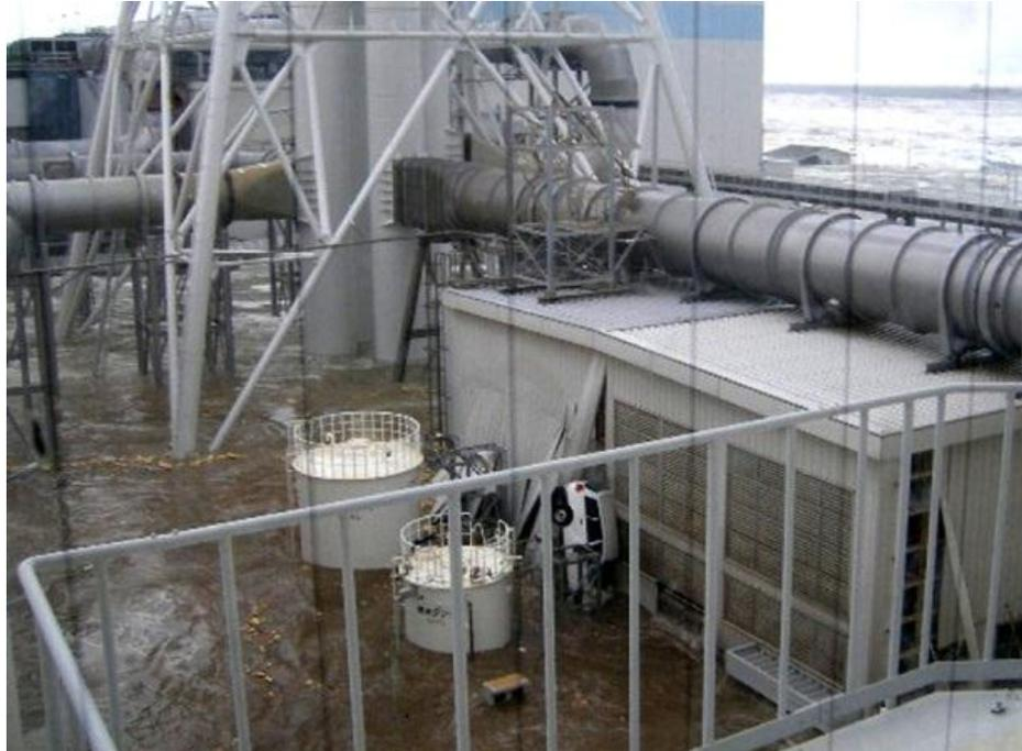
Abbildung 16: Überflutete Anlage von Fukushima Dai-ichi (MOPO F., 2016)
