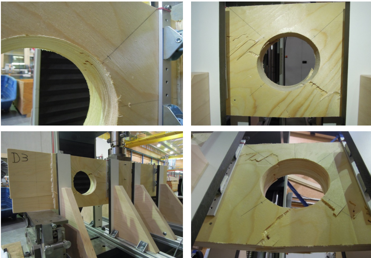
Abb. 3.14 Erstrissbildung am oberen Durchbruchrand bei D1 (oben links), Aufreißen der Verstärkungsplatten im Winkel von 45^\circ bei D1 (oben rechts), Schubversagen bis zum Trägerende bei D3 (unten links) und Biegeversagen im Nettoquerschnitt bei D2 bei Weiterbelastung des Prüfkörpers nach dem Schubbruch (unten rechts)
