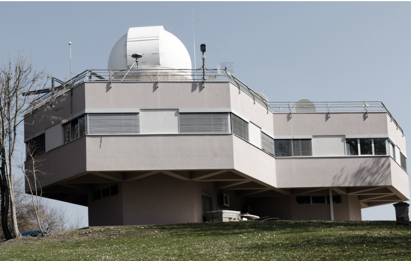
Abb. 1 Bestandsgebäude Observatorium Lustbühl
