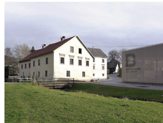
Abb. 32 Ansicht von Stahlmüller Wiese
