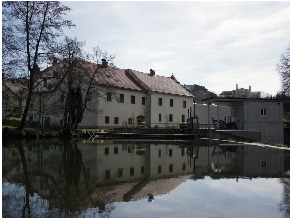
Ansicht vom westlichen Mühlufer
