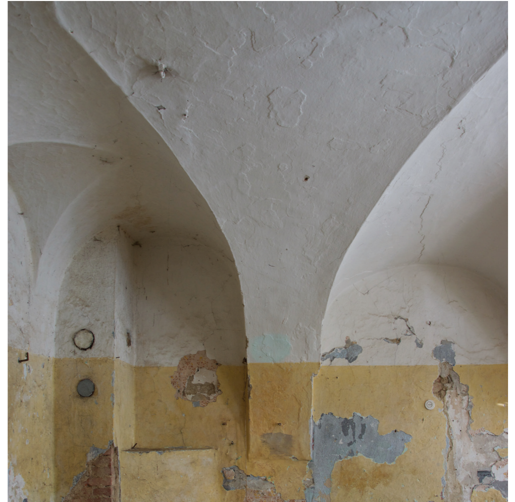
Komplexe Gewölbegeometrie im Erdgeschoß des 2er Hauses
