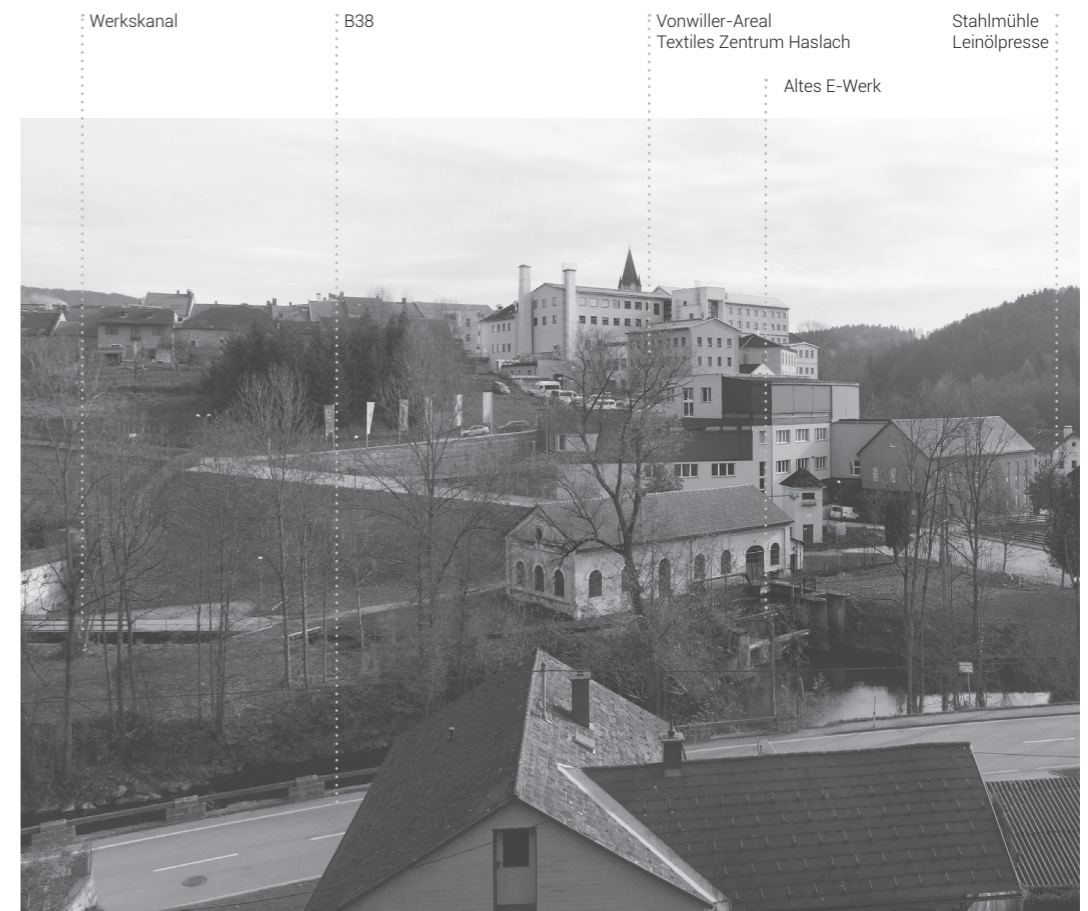
Abb. 29 Ansicht von Felberauerstraße 2
