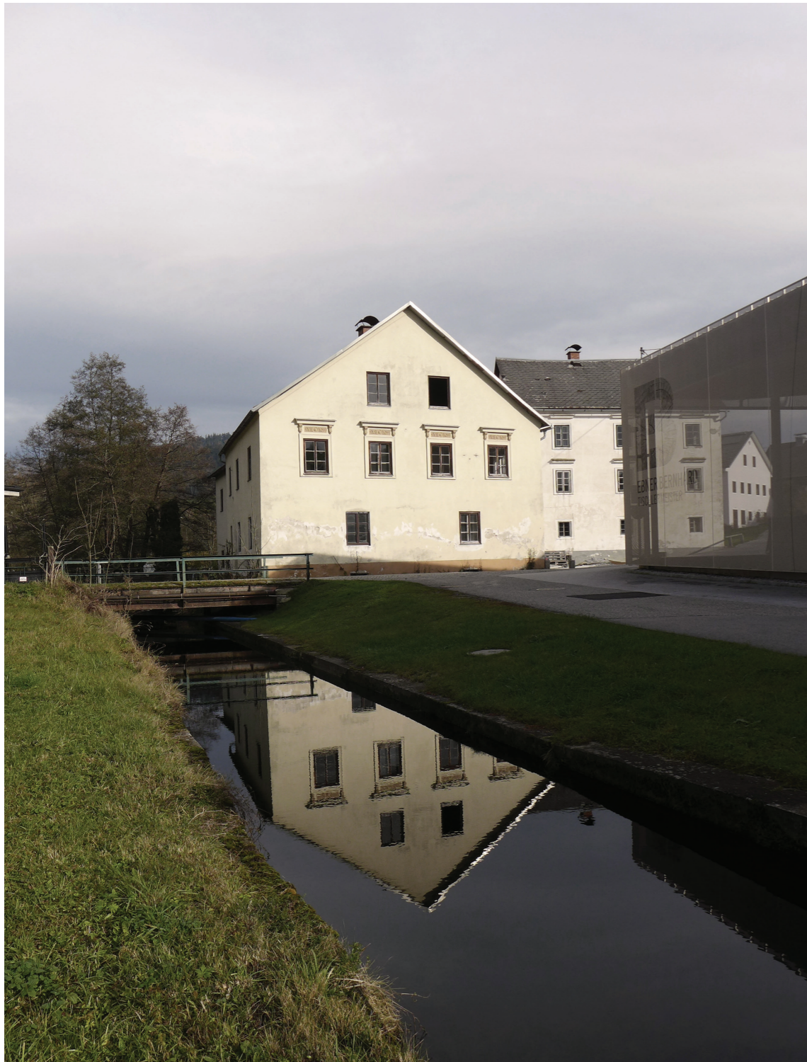
Abb. 31 Ansicht von Stahlmüller Wiese, vorne der Werkskanal
