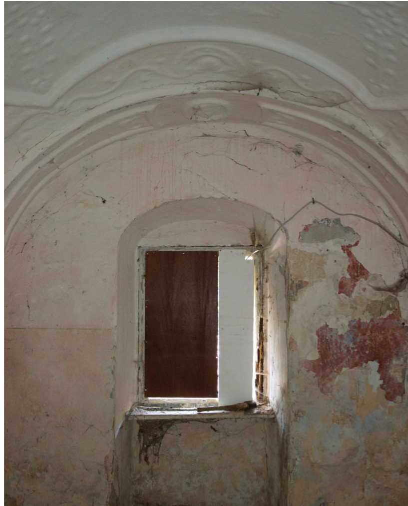
Rundbogengewölbe mit Stuckarbeiten
