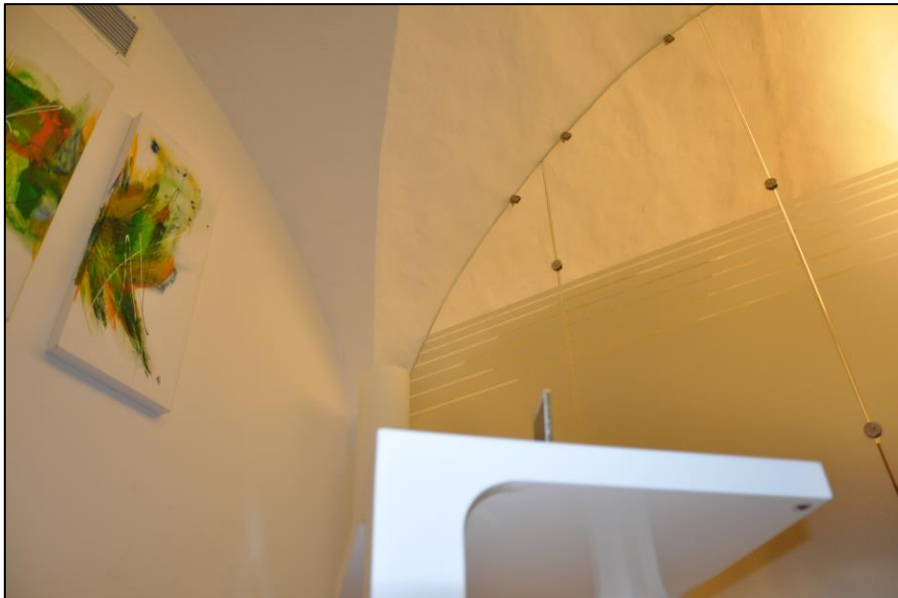
Abb. 28 Andeutung der baulichen Struktur (Gewölbe) und der Klimatisierungsautomatik
