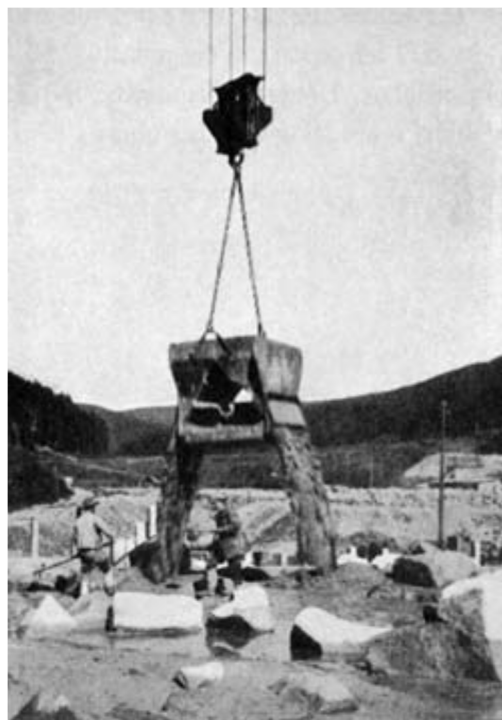
Abbildung 2.6: Betonage eines Damms in Deutschland im Jahre 1920 [6]
