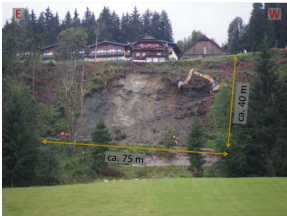
Abb. 1-1: Gumpenbergrutschung im Juni 2013 kurz nach dem Rutschungsereignis; Aufnahme: Das Land Steiermark (2013)
