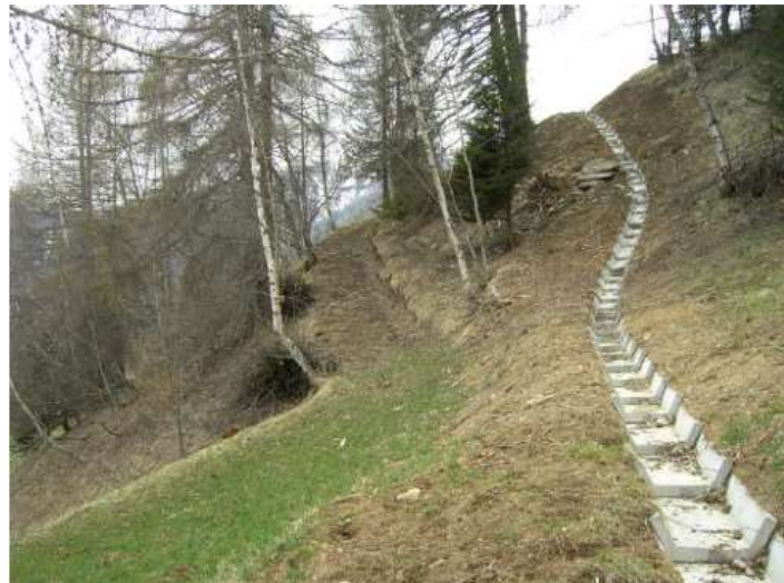
Abb. 8-1: Graben mit Betonhalbschalen (nach Krättli & Schwarz 2015)
