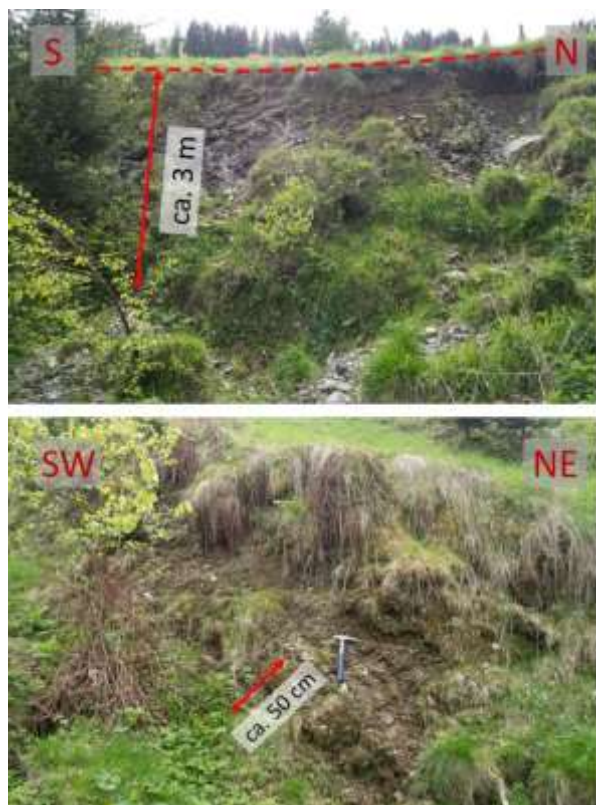
Abb. 4-30: Abrisskante (oben) und Verebnungsfläche mit Zerrspalte (unten) bei WP15
