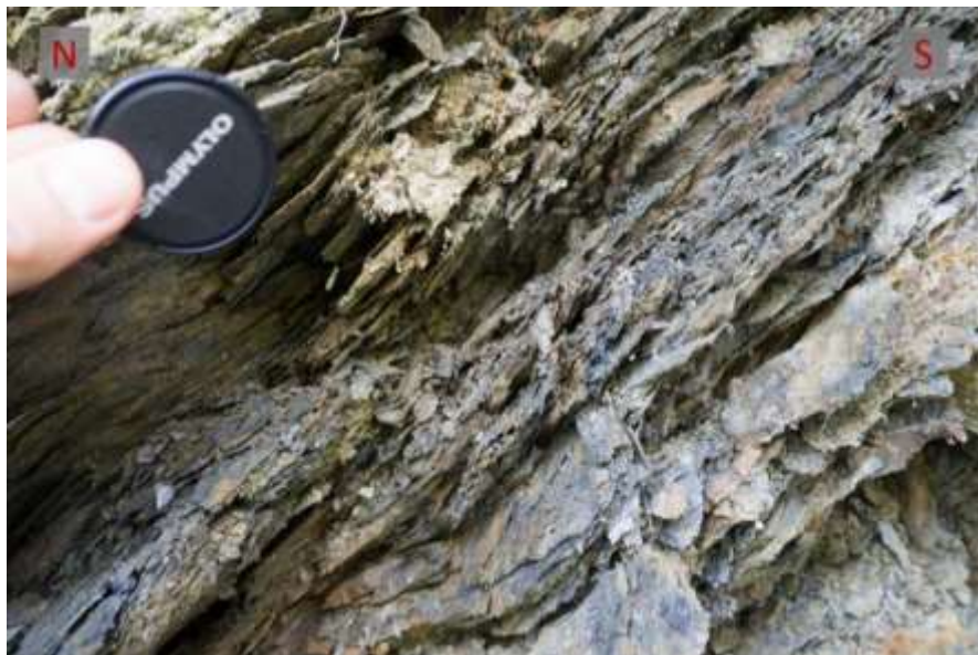
Abb. 4-6: Phyllitaufschluss: Sf-parallele Störung und außerordentlich engständig zerlegter Bereich bei WP3
