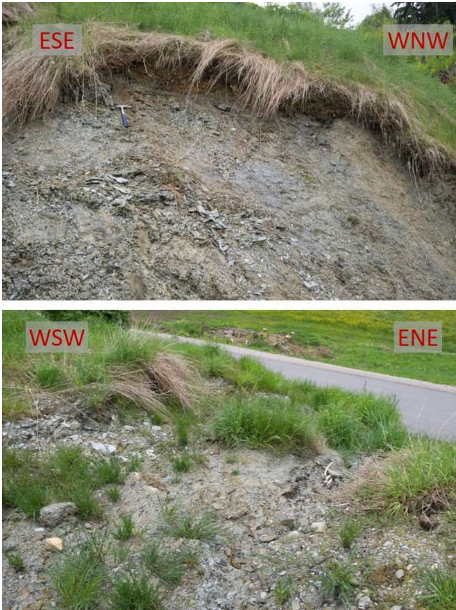
Abb. 4-23: Sekundärabriss bei der Gumpenbergrutschung (oben) und Ausschwämmen der Rutschmasse durch Niederschläge (unten)
