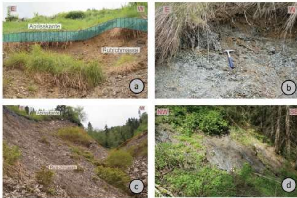
Abb. 4-5: charakteristisches Erscheinungsbild von Rutschmassen im Arbeitsgebiet; a, b: WP90 direkt bei der Gumpenbergrutschung; c (WP24), d (WP14): beide im Gumpenbachgraben aufgenommen
