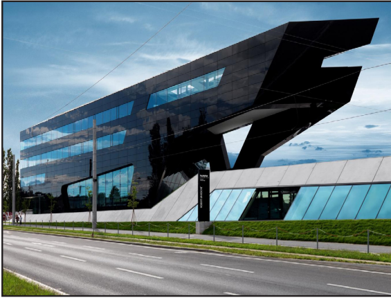
Abb. 107: mp09 von GSarchitects
