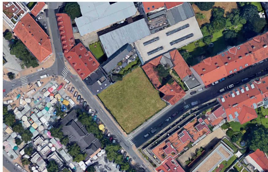
Abb.13 Bauplatz von oben
