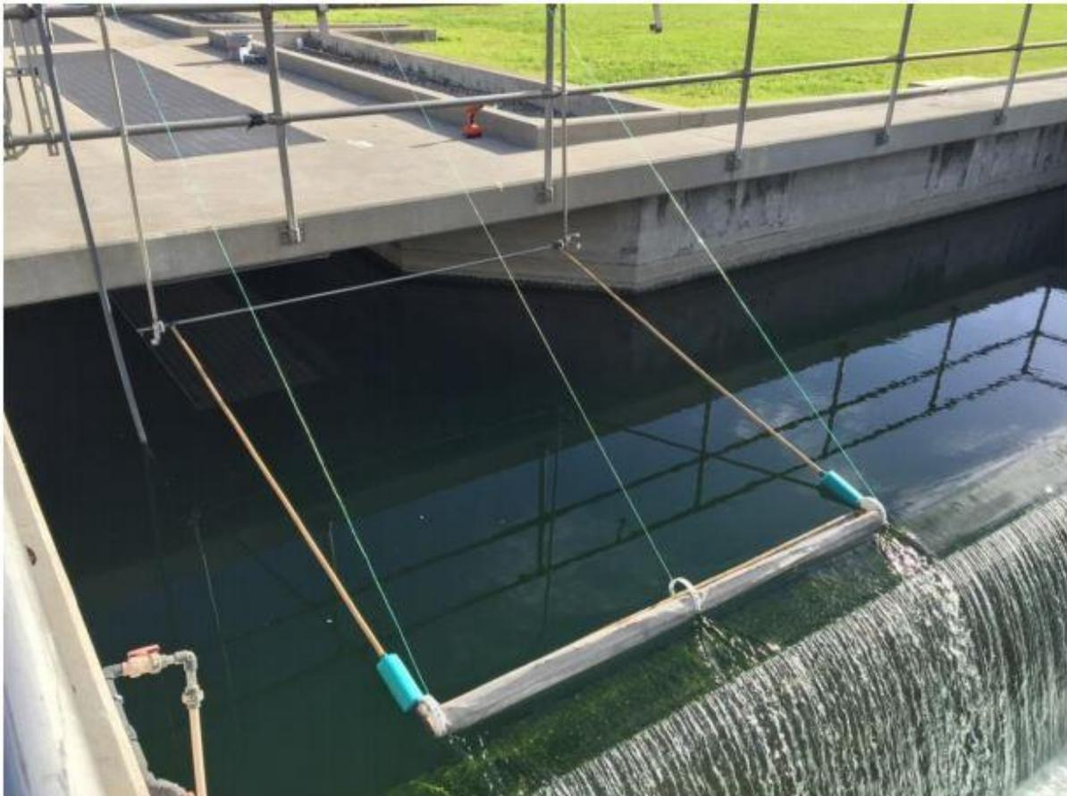
Abbildung 4-19: Foto vom acht Fuß langen Sieb in der Abwasserreinigungsanlage 1 des Bezirkes Los Angeles (Carr et al., 2016)
