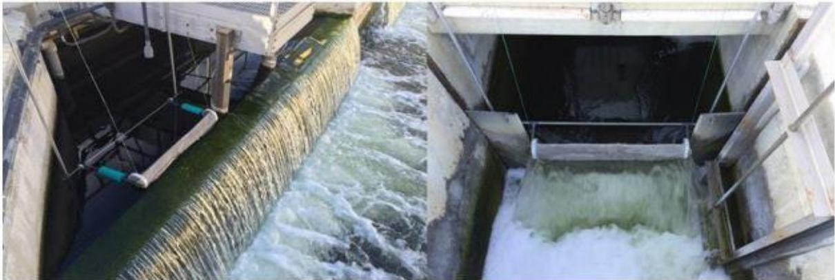
Abbildung 4-18: Fotos vom vier Fuß langen Sieb in der Abwasserreinigungsanlage 3 und 7 des Bezirkes Los Angeles (Carr et al., 2016)
