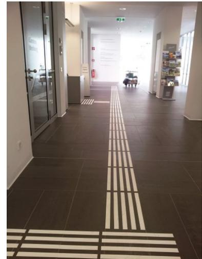
Abb. 80: Beispiel eines stark kontrastierenden, taktilen Leitsystems
