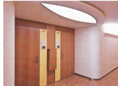
Die Breite der Zimmertür ist mit 80cm ausreichend, auch eine geteilte Stand- und Bedarfstür ist nicht nötig, da im Notfall eine schmale Transportliege verwendet werden kann.
