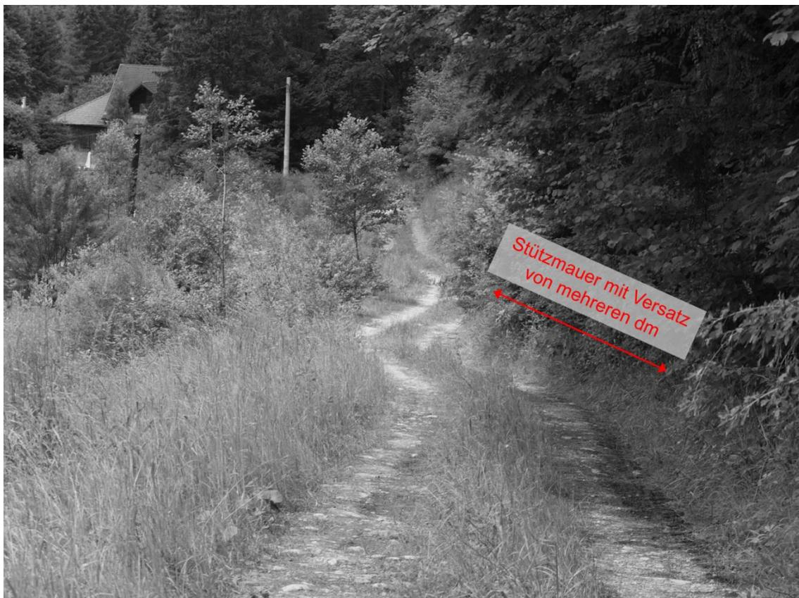
Abb. 16 Südlicher Fußbereich der MB, Versatz des Forstweges und der Stützmauer erkennbar
