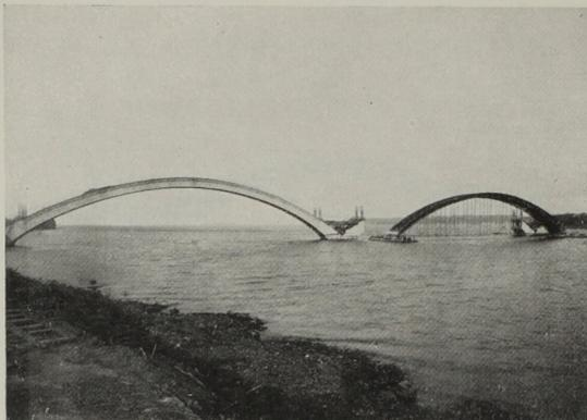
Fig. 10. Mise en place du cintre pour le coulage du 2<sup>e</sup> arc
