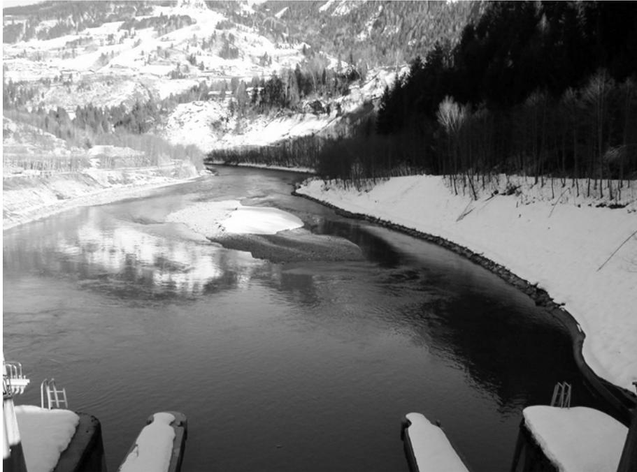
Abbildung 1.2: Verlandung im UW, 16.03.2005 ( $Q = 32 \text{ m}^3/\text{s}$ )
