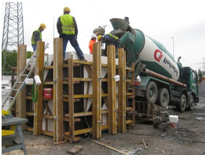
Abb. 2.1.: Probewürfel zur Ermittlung der quasi-adiabatischen Temperaturerhöhung
