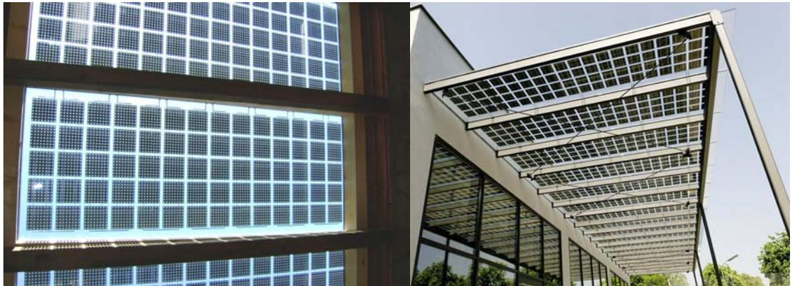
Abb.3.38: Ausführungen mit unterschiedlicher Transparenz, Quelle: ertex-solar [22]
