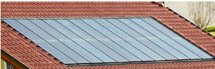
Abb.3.37: Integrierte Anlage Quelle: ertex-solar [22]
