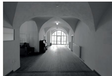
Abb. 33: Gewölbekonstruktion,
