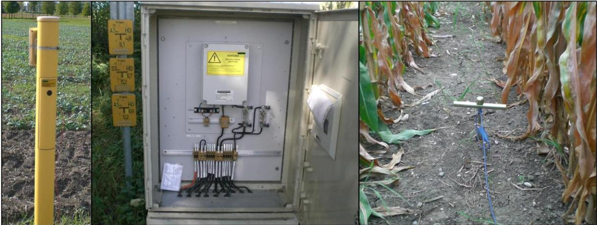
**Abbildung 6.3:** Messmarker, Schaltschrank und Erdspieß für ferne Erde
