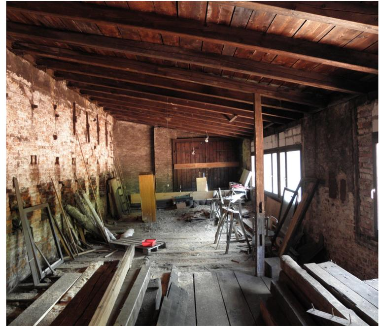
*Unten: Auf dem Foto ist der ursprüngliche Verlauf des Ortganges gut zu erkennen. Er verlief etwa von der Höhe der Laterne in Richtung der unteren, rechten Ecke des Tores. Es ist auch gut zu sehen, dass nach dem Abbruch des Daches angefallenes Material des Bruchsteinmauerwerks mit einbezogen wurde.*
