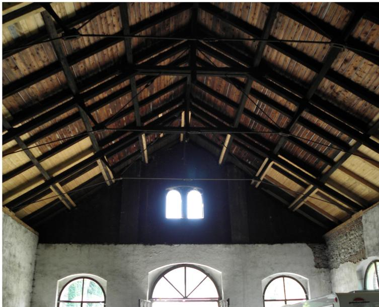
Unten rechts: Das Foto zeigt die tragende Konstruktion entlang der Schnittlinie der beiden Dächer der Gieß- und Abstichhalle. In der Abstichhalle wurde das Dach zur Gänze rekonstruiert.
