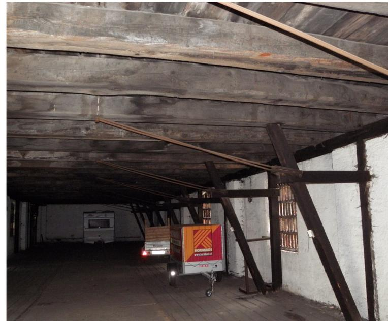
*Unten: Bei der Dachkonstruktion handelt es sich um ein Pfettendach mit Kehlbalken, das von einer Steher-Konstruktion getragen wird.*
