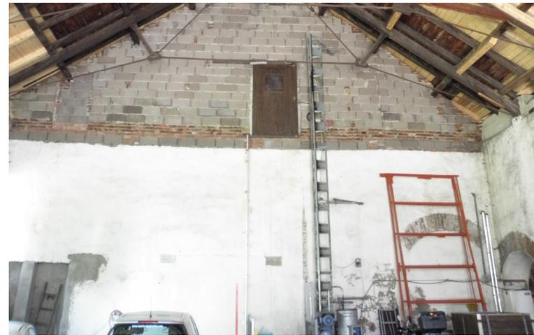
Unten links: Das Bild zeigt das Dach der Gießhalle, bei der es sich um eine Dachbinderkonstruktion handelt. In der hier vorliegenden Form spannt eine Stahlkonstruktion die Binder aus und wird zusätzlich durch Kehlbalken verstärkt. Auf den Bindern liegen die Pfetten auf, die ihrerseits die eigentlichen Sparren tragen. Es ist deutlich zu sehen, dass erst vor kurzem Ausbesserungsarbeiten und, wo nötig, Verstärkungen der Konstruktion durchgeführt wurden.
