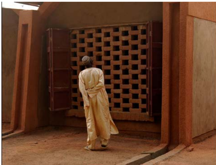
Abb. 1.2.2.16 | LEHRERUNTERKUNFT, GANDO ZIEGEL, DIE MIT AUSSPARUNGE ÜBER EINANDER GESCHICHTET WURDEN BILDEN DIE HAUPTFASSADE. MIT EINFACHEN MITTELN WURDE AUF DIESE WEISE DURCHLÜFTUNG, SONNENSCHUTZ UND BELICHTUNG GEWÄHRLEISTET.
