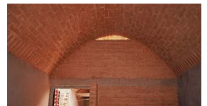
Abb. 1.2.2.18 | INNENANSICHT LÜFTUNGSSCHLITZ IM DACHBEREICH
