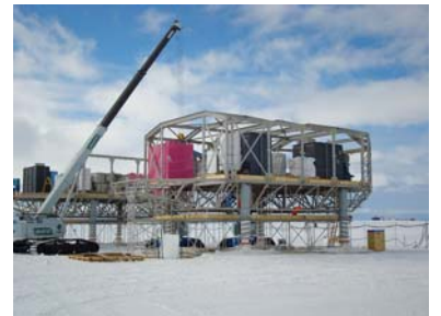
Abb. 1.1.4.12 STAHLKONSTRUKTION MIT TECHNIKMODULEN
