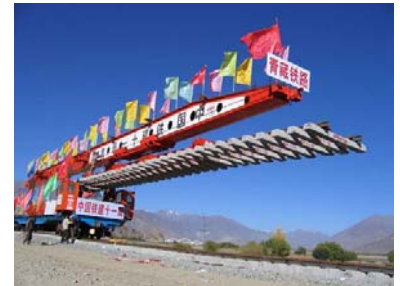
Abb. 1.1.3.4/1.1.3.5 SCHIENENTRANSPORT UND VERLEGFAHRZEUG
