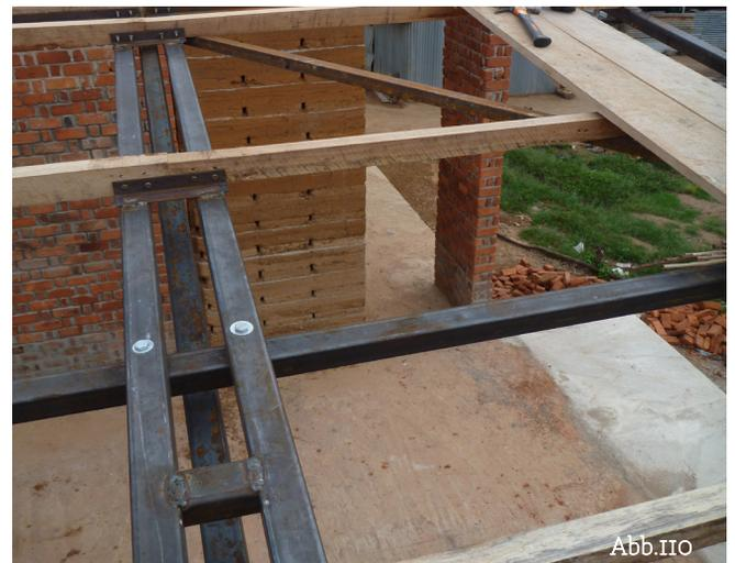
mal zur Trägerachse ein 50,8 mm x 50,8 mm x 2mm Formrohr an den Kreuzungspunkten mit dem Träger mittels M12 Schrauben und Muttern befestigt. Mittig zwischen zwei Achsen kam dann parallel zur Trägerachse ein weiteres Formrohr. An diesem wurden dann auch gebohrte L-Profile angeschweißt, wodurch man einerseits die Dachlatten gerade ziehen konnte und die außerdem ein weiteres Auflager für die Dachlatten bildeten.
