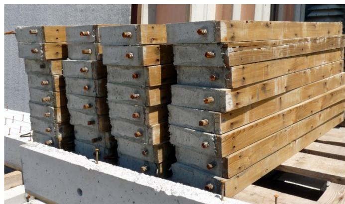
Abb.7 Vorproduzierte Stützrippen
