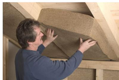
Abb.34 Dämmfilz aus Flachsfasern
