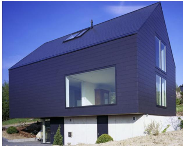
Abb.40 Fassade aus kleinformatischen Faserzementplatten
