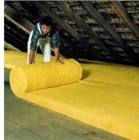
Abb.26 Mineralwolle - Dämmrolle
