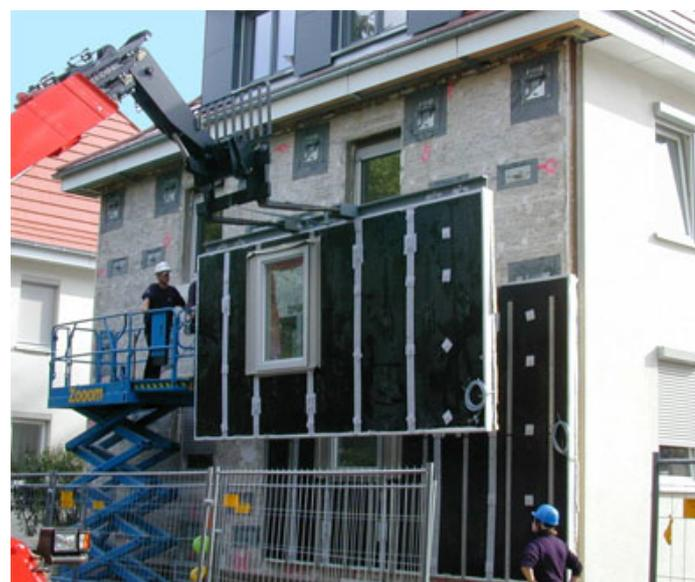
Abb.27 Montage der Elemente mit Spezialtraverse
