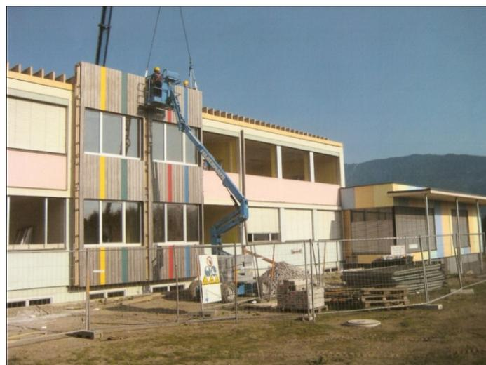
Abb.38 Montage der vertikalen Fassadenelemente
