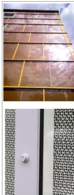
Abb.33 Fassadengliederung durch GAP-Elemente
