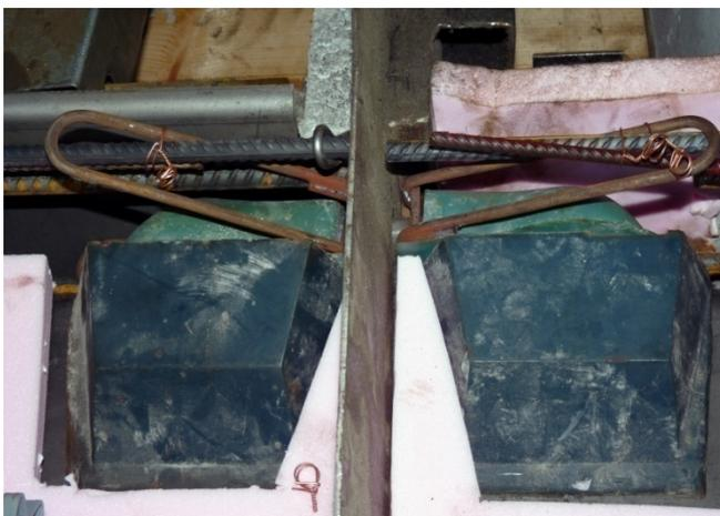
Abb.12 Elementstoß stumpf
