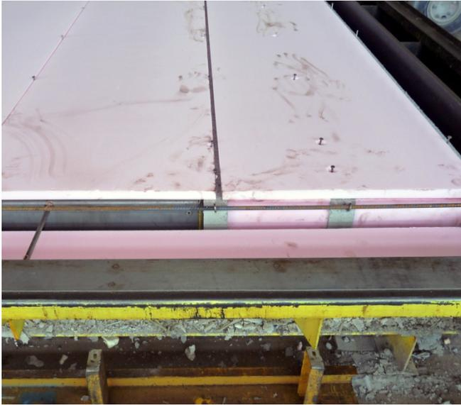
Abb.16 XPS-Platten auf Stützrippen
