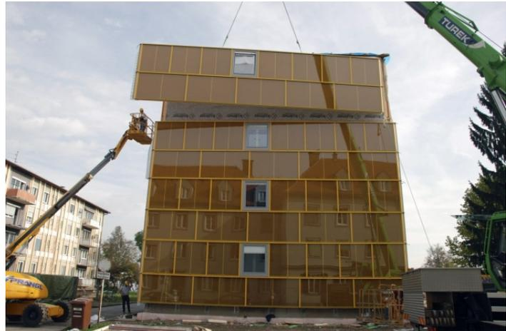
Abb.32 Montage der Elemente auf vormontierte Ausgleichsdämmung
