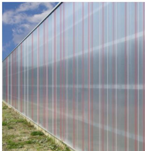
Abb.44 Kunststofffassade aus Polycarbonat
