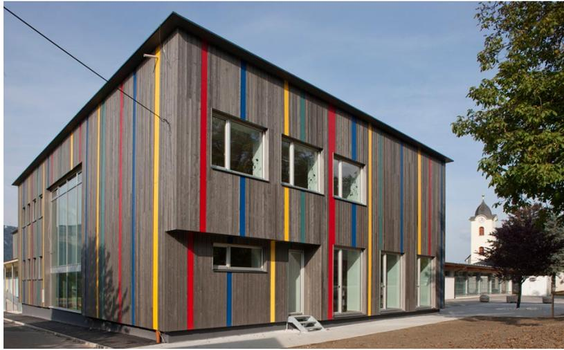
Die im Jahre 1964 errichtete Volksschule liegt in St. Leonhard bei Siebenbrünn in Kärnten und wurde im Bereich der Gebäudehülle und mit dem Einbau einer zentralen Komfortlüftungsanlage in Passivhausqualität saniert.
