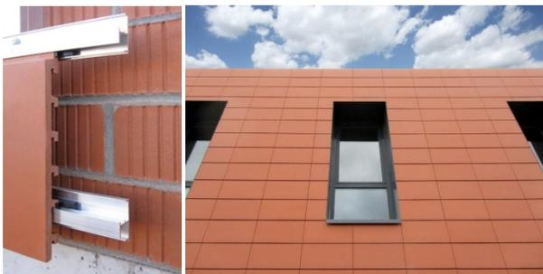
Abb.41 Ziegelfassadenbekleidung -
