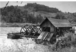
Die am Ufer gebaute Krobath-Mühle in Misselsdorf bei Mureck wurde ähnlich wie die heute noch bestehende Babič-Mühle in Slowenien mittels Transmission vom Wellrad der Schiffe angetrieben.
