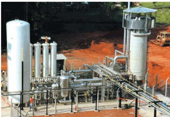
Abbildung 18: Methan-Brenngaserzeugungssystem ( $30000\text{Nm}^3/\text{d}$ ) [54]
