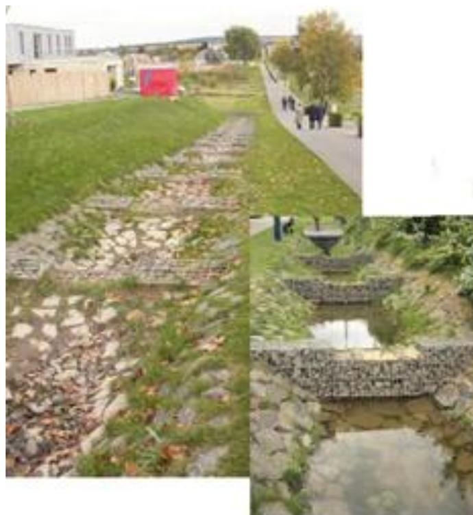
**Abbildung 6-7: Kaskadenförmige, offene Retentionsteiche (EAU, n. b.)**
