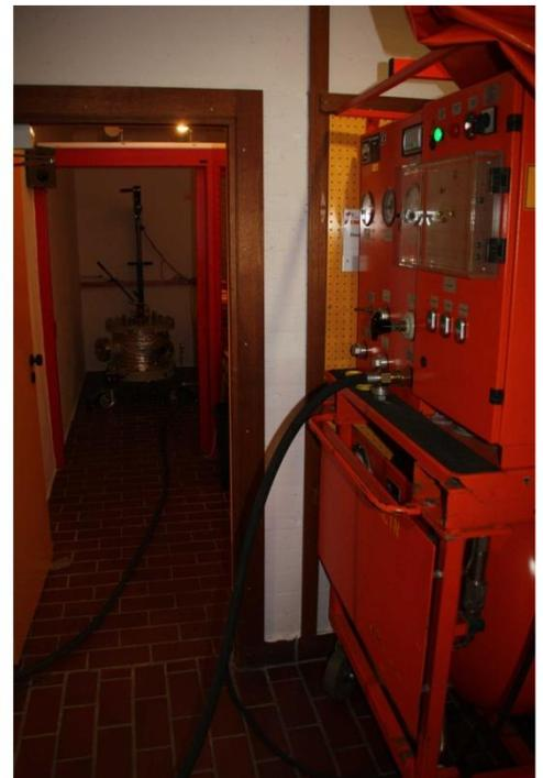
Abb. 6.16 a) Gaswartungsgerät R120R01 mit zusätzlicher Saugpumpe B044R02 der Firma DILO    b) Gaswartungsgerät beim Absaugen und Speichern von  $\text{SF}_6$  aus dem Kessel
