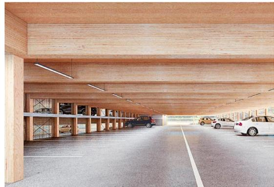
Abbildung 31: links: Produkte aus BauBuche; rechts: möglicher Einsatzbereich der Baubuche (Pollmeier Furnierwerkstoffe GmbH, 2014a)
