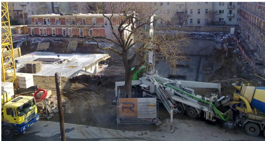
Abbildung 18: Betoneinbringung mittels Autobetonpumpe<sup>95</sup>
