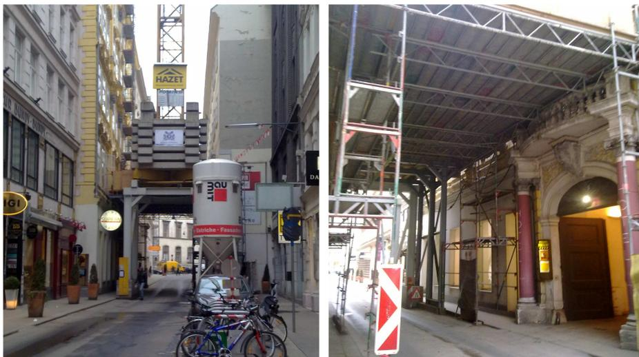
Abbildung 17: Links: Frontalansicht des Turmdrehkrans auf Portal der Fa. Hazet in der Habsburgergasse 5 in 1010 Wien; Rechts: Detailansicht des Portals mit Einfahrt zum Innenhof<sup>92</sup>
